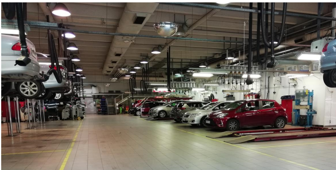
Kuva 16. Yleiskorjaamohalli. Lattiassa keltaisella merkitty työpisteiden rajat.
