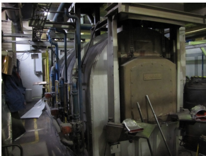
Kuva 5. Käytöstä poistettava tunneliuuni.
