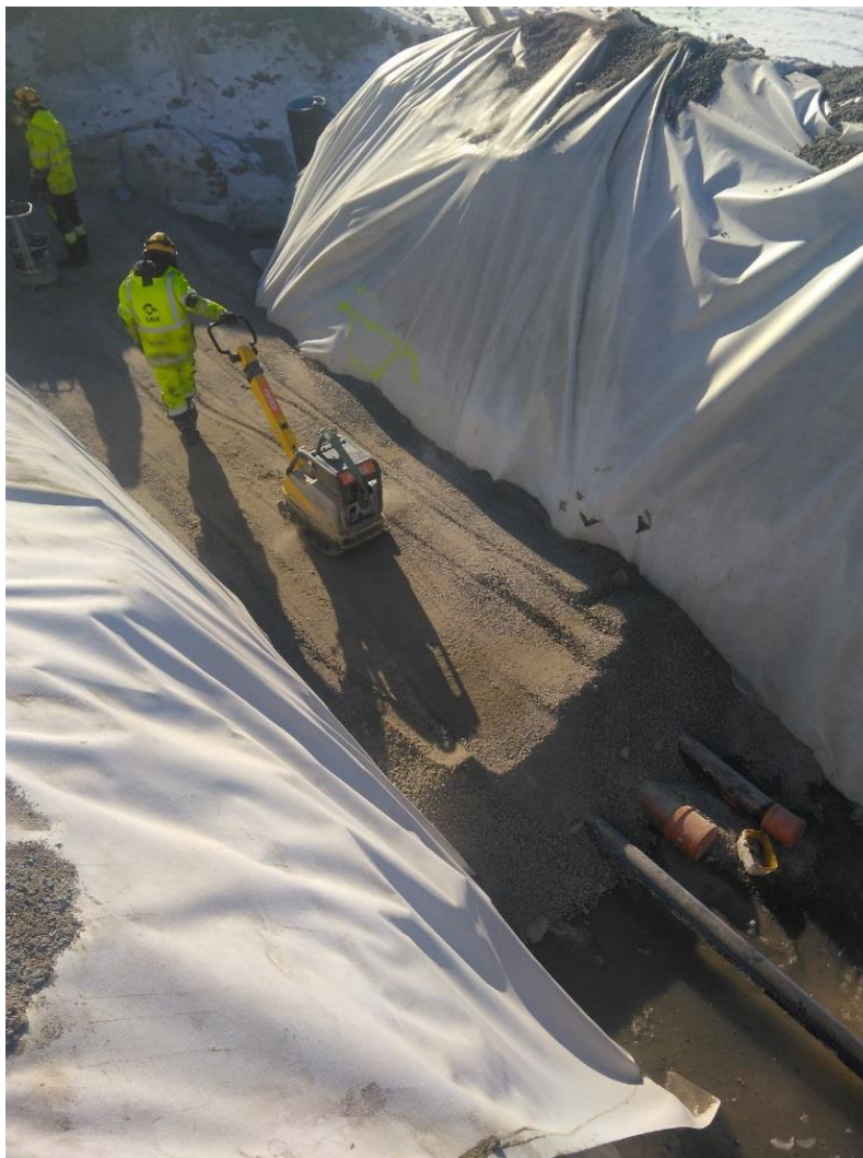
KUVA 9. Vesihuoltokanaali Äänekoski (Pehkonen 2018-04-11)
