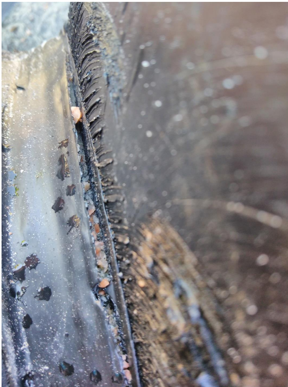
KUVA 15. Kaivon hitsausseura ( Pehkonen 2018-05-20)
