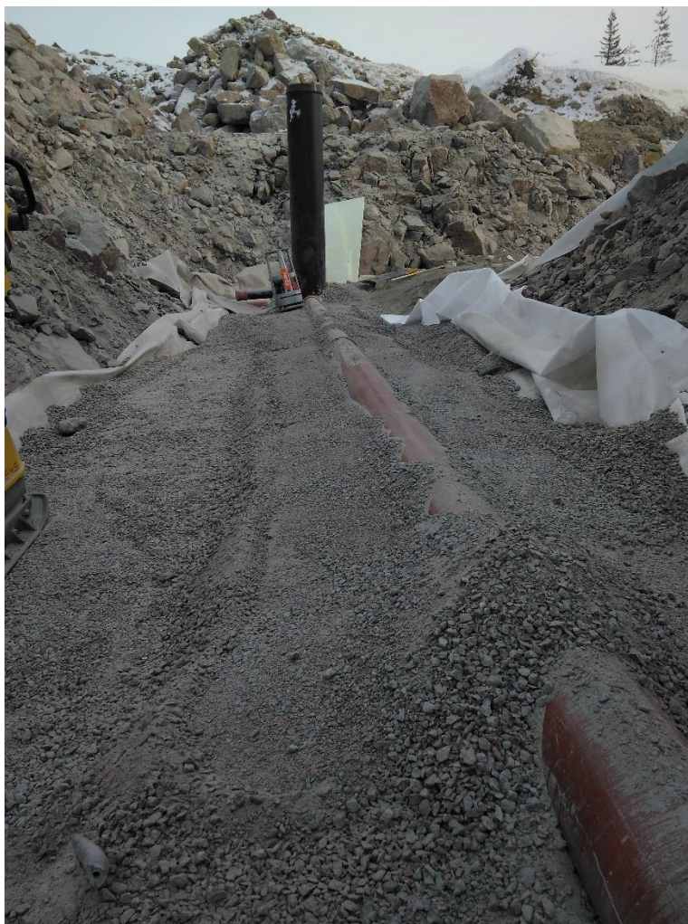
KUVA 7. Jätevesiviemäri Kiepin katu (Pehkonen 2018-04-16)
