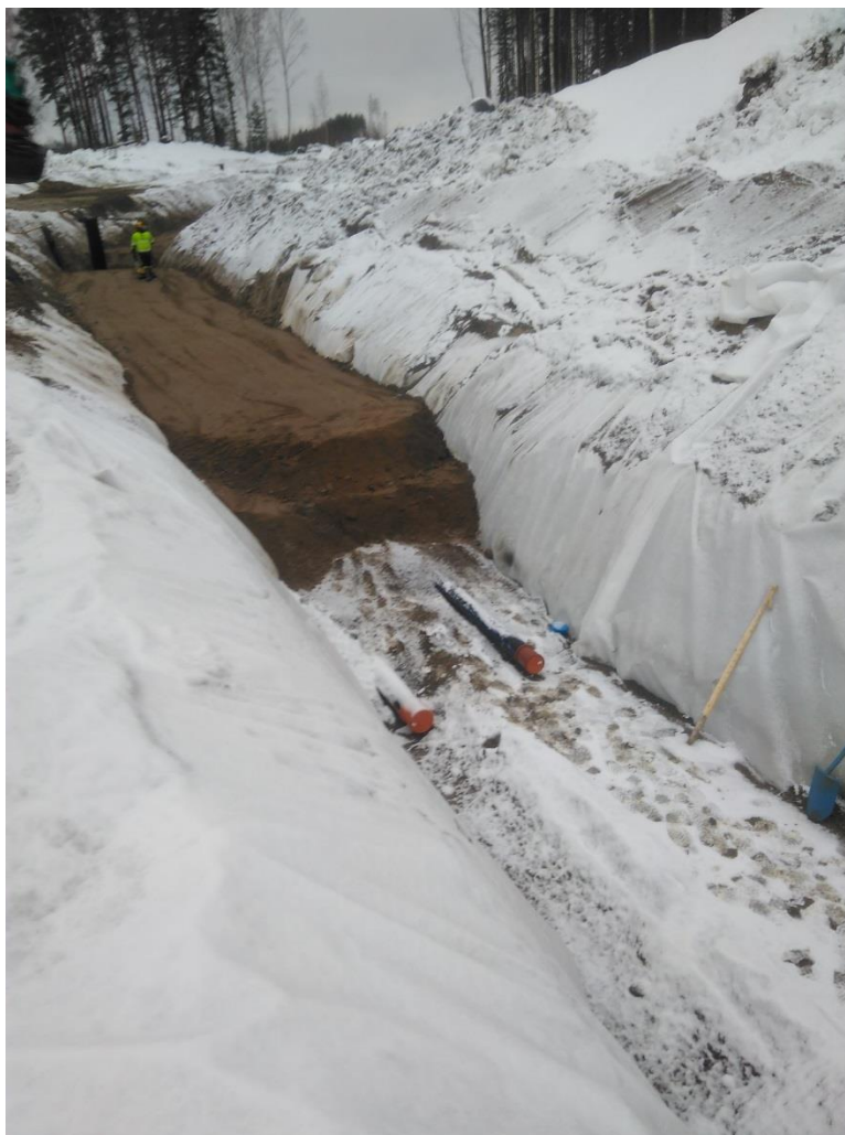
KUVA 12. Vesihuoltokanaalin täytön kerrokset (Pehkonen 2018-04-11)
