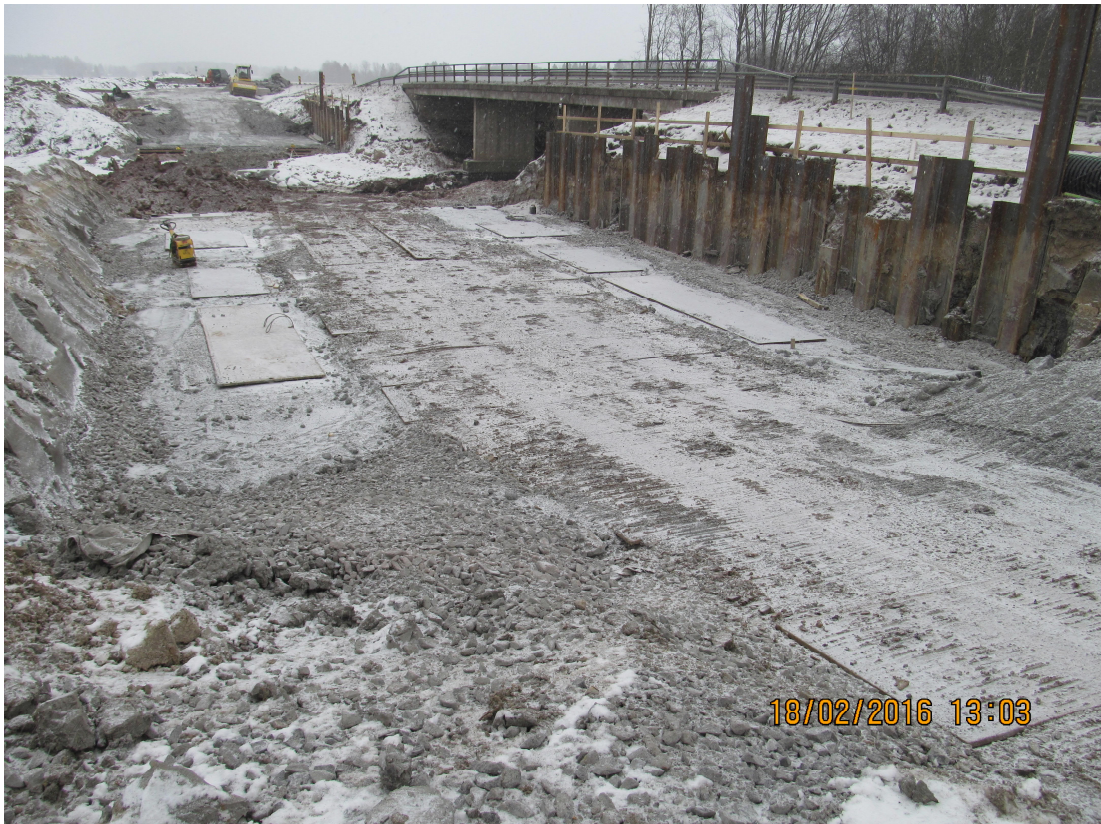
Kuva 5: Rakentamisalue ja ponttiseinä Ulvilassa
