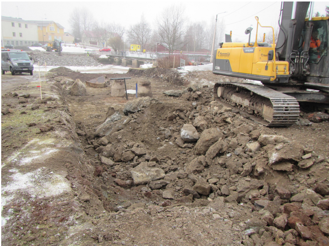
Kuva 6: Maanleikkaukset käynnissä Pomarkussa
