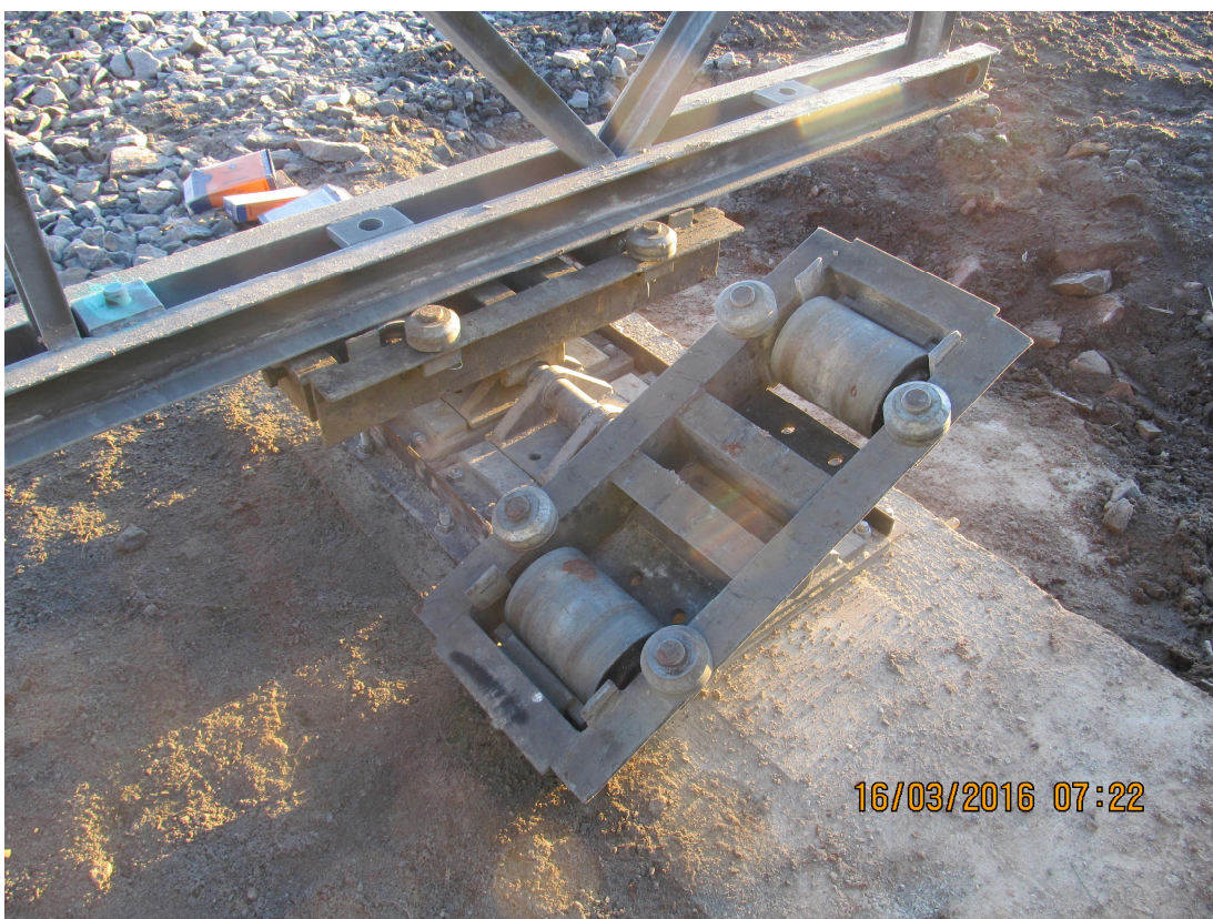
Kuva 9: Kaksi tukirullaa asennettuna Ulvilassa
