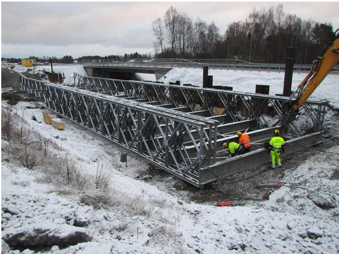
Kuva 13: Varasillan purkaminen käynnissä Ulvilassa
