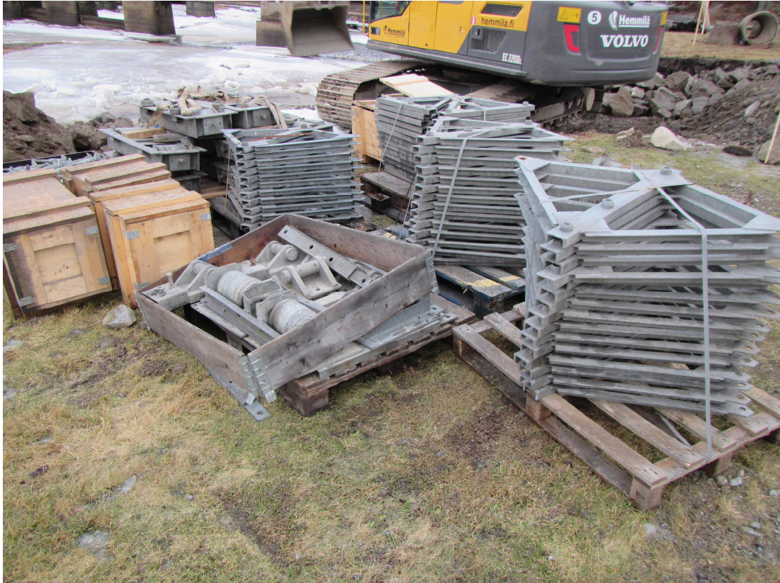
Kuva 4: Varasiltakalustoa välivarastoituna Pomarkussa työmaalla
