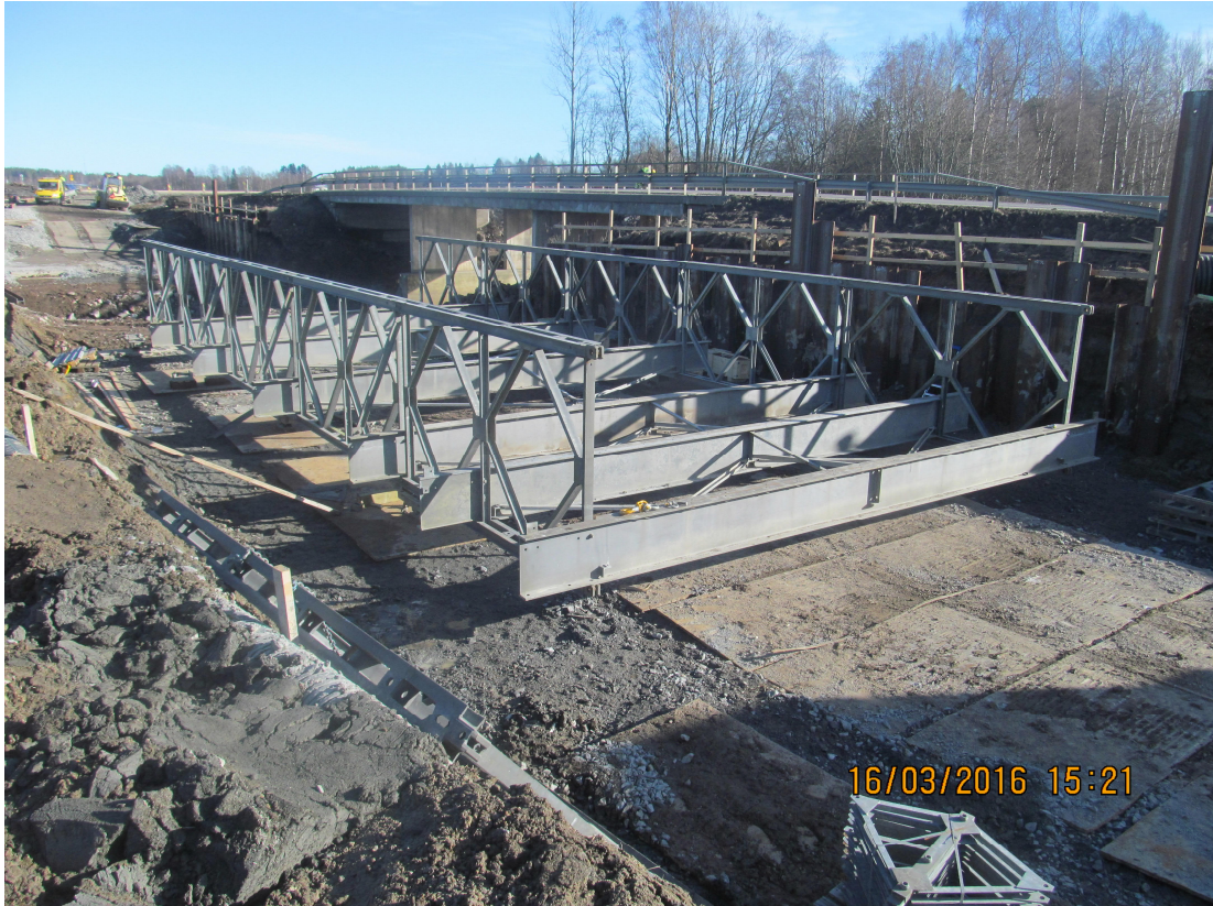
Kuva 2: Keskeneräinen varasilta Ulvilassa
