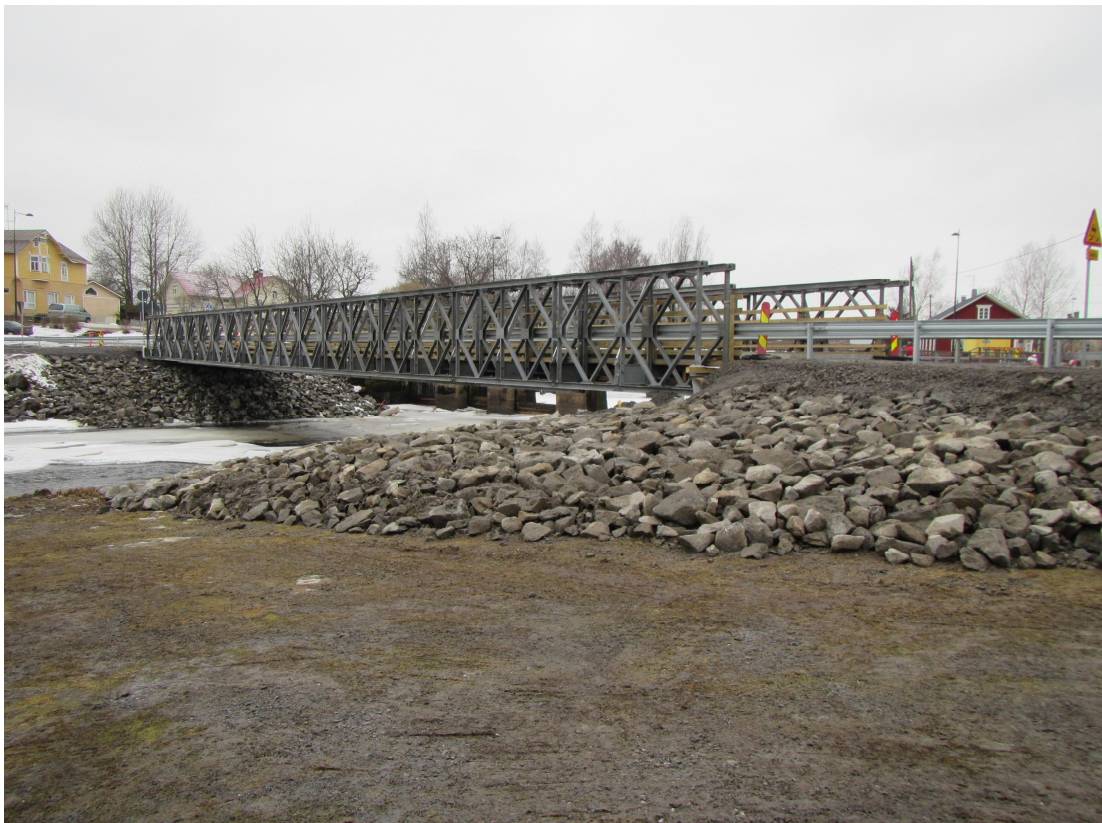
Kuva 12: Valmis varasilta Pomarkussa
