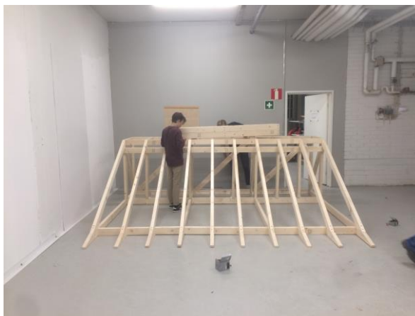
Figur 2. Bild från andra byggtillfället, 30.10.2018
