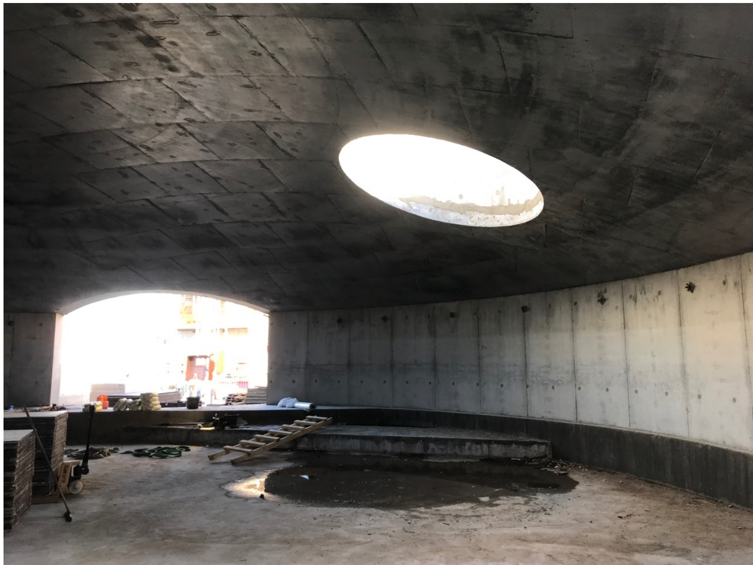
Kuva 28. Kylätalo rakentuu (Horto 2018).
