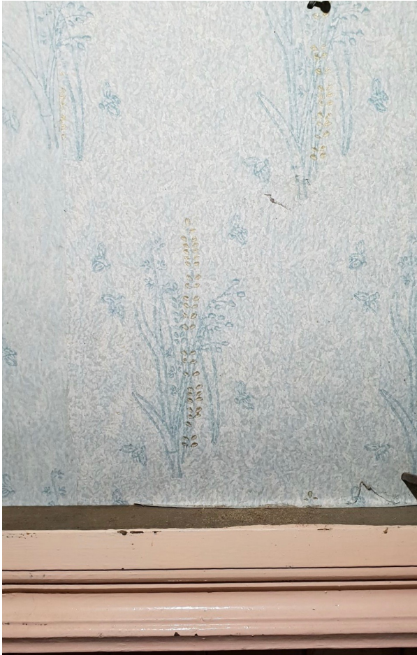
Kuva 16. Seinäpintaa portaikon alla
