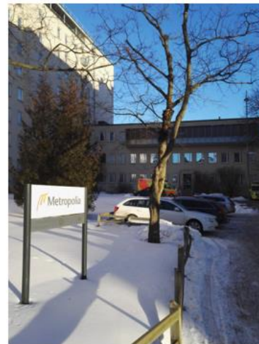
Metropolian Tukholmankatu 10:n toimipiste takapihalta kuvattuna. Kuvassa näkyy C-käytävä ja B-torni.
