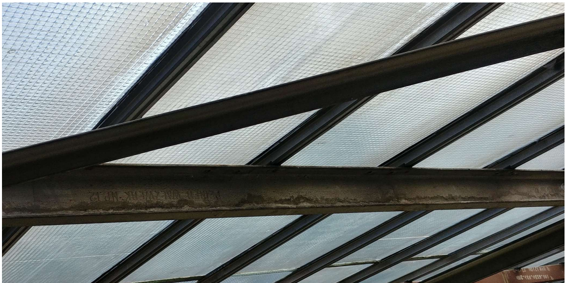
Kuva 12. Pörssitalon vanhat rakenteet
