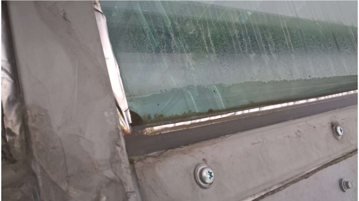
Kuva 1. Ala-vaakalistan padottama vesi
