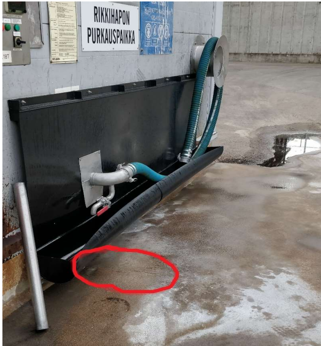
Kuva 5 Rikkihapon purkauspaikka. Halkeama ympyröity. (Kuronen 2018)
