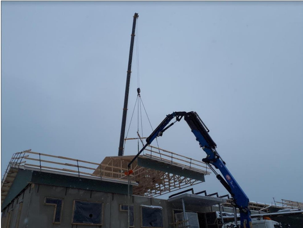
Kuva 7. Kattolohkon nosto.
