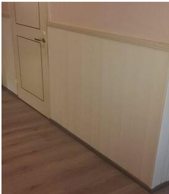
Kuva 20 Eteisen puolipanelointi (Kokkonen, 2018-18-08)
