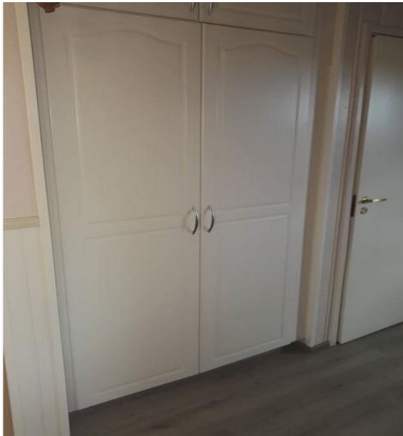
Kuva 24 Uusittua kaapistoa (Kokkonen, 2018-04-08)
