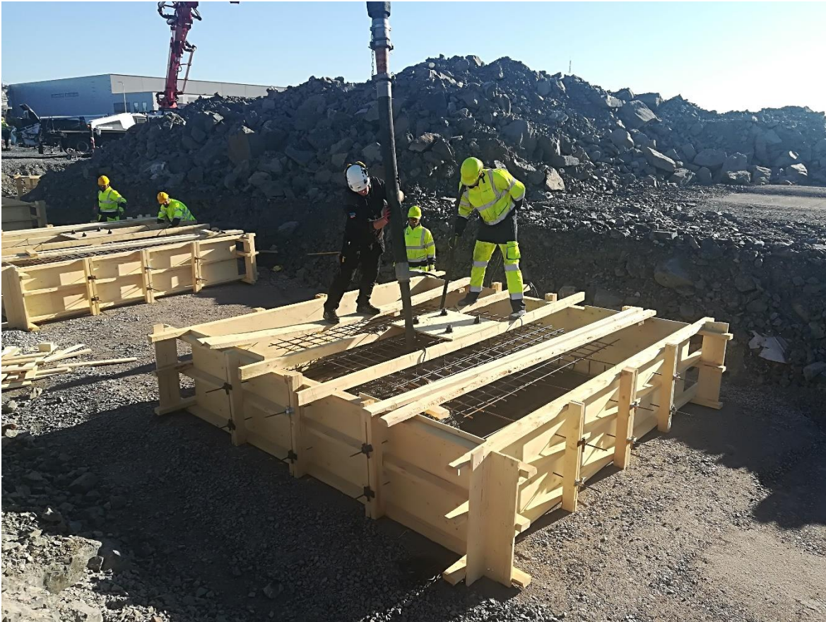
Kuva 2. Ensimmäisen pilarianturan valu.
