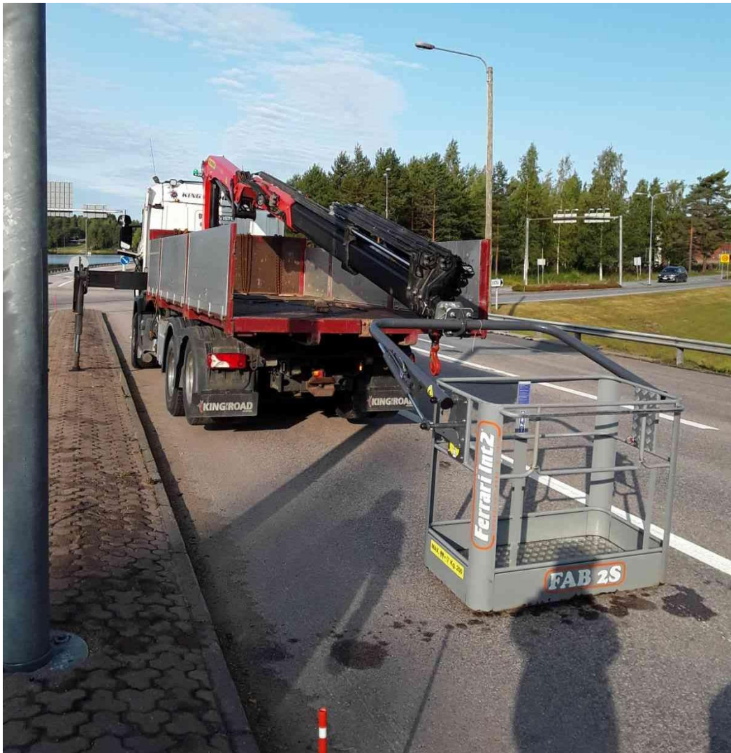
Kuva 10. Tarkastuksessa käytetty nostokoriaauto.
