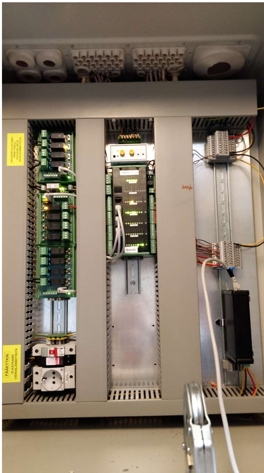
KUVA 11. Uusi saneerattu alakeskus. (Rönkkö 2018)
