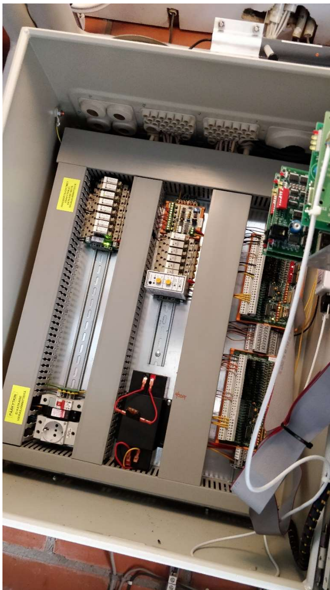
KUVA 3. Alakeskus ennen saneerausta. (Rönkkö 2018)
