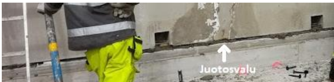
KUVA 11. Juotosvalu asennuksen aikana
