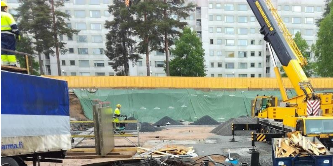
KUVA 6. Elementtien välivarastointia kampatelineisiin
