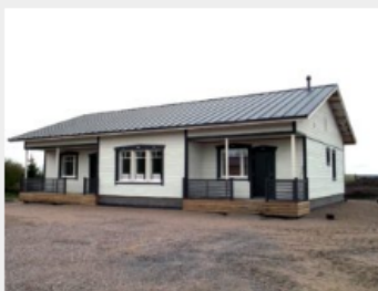
— Rakennusliike Harju-Heikkilä Oy:n rakentama omakotitalo Kauhajoella
