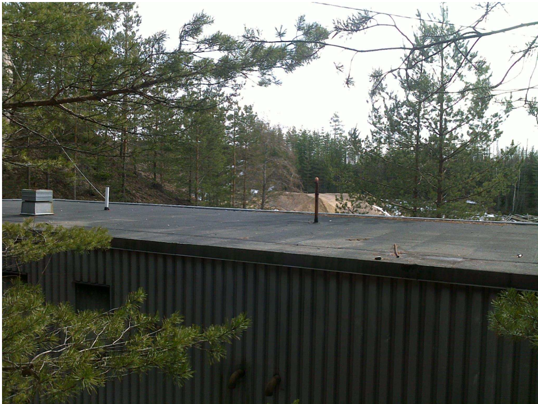
Kuva 6 Toimisto-osan huopakate
