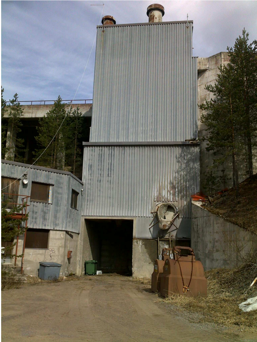
Kuva 5 Tehtaan osan julkisivu
