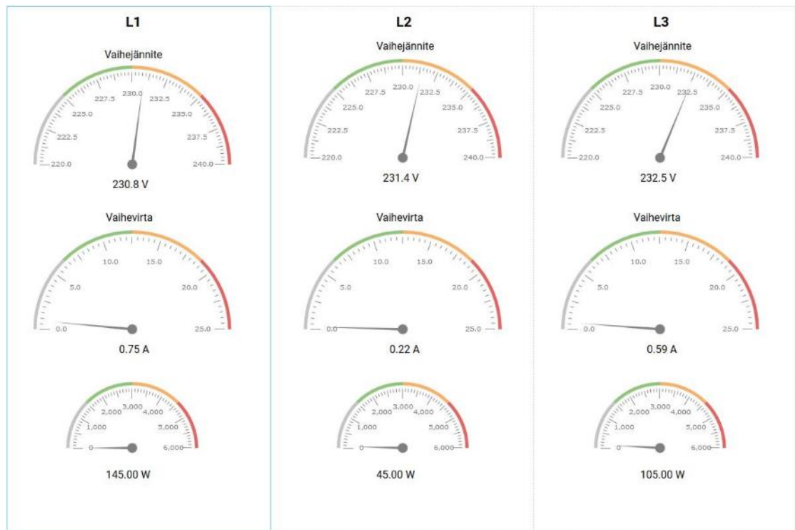
KUVA 61. Lähtötilanne, vain peruslaitteita ja valaistusta päällä
