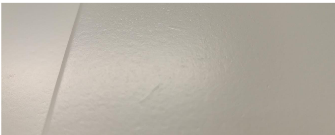
Kuva 5. Kuitujen nousua ja epätasaisuutta valmiissa maalipinnassa
