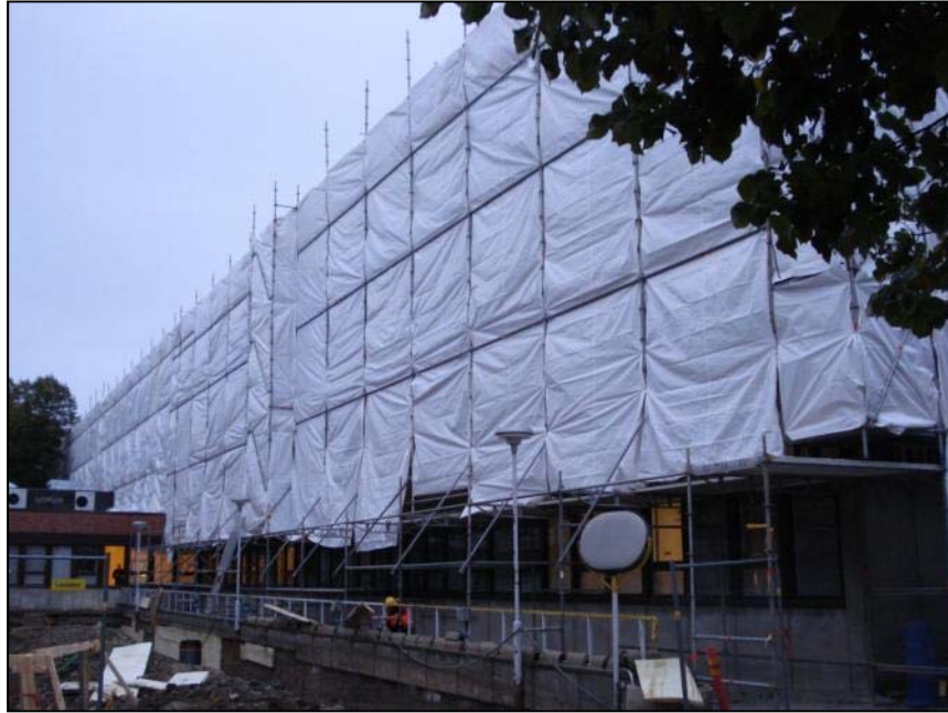
Kuva 2. Sääsuojattu moduulijärjestelmäteline asennettuna ajoluiskan päälle (Kuva: Antti-Pekka Kortelainen).
