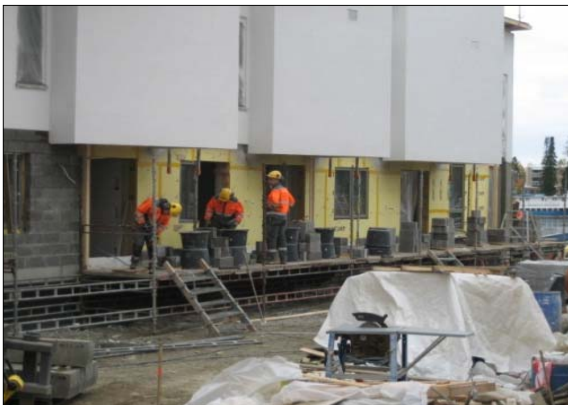
Kuva 4. Hakitelineet tehokkaassa käytössä rakennusmiesten kasaamina.
