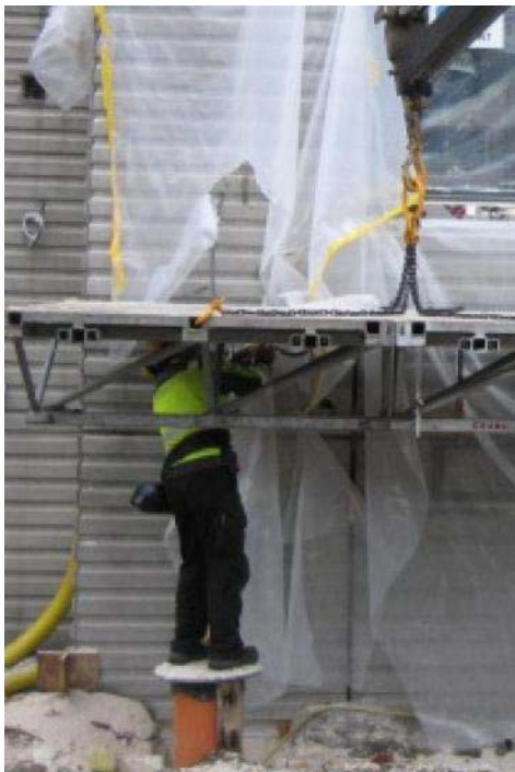
Kuva 32. Asentaja kaapelikela työalustanaan.
