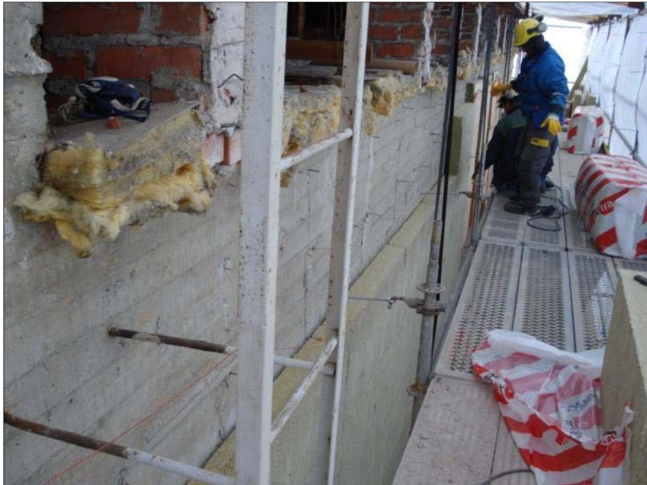
Kuva 11. Moduulijärjestelmäteline on leveydeltään sopiva moniin asennustöihin. Ilman muurauskonsolia teline ei kuitenkaan sovellu käytettäväksi muuraustyöhön.
