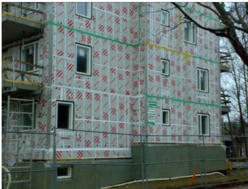
Kuva 18. Päätyseinän muoto tekee mastolavatyypin valinnasta hankalan ja aiheuttaa helposti yhden turhan mastolavan siirtokerran.
