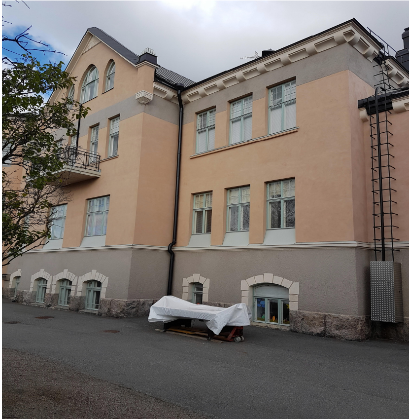
Kuva 8. Linnunlaulun päiväkotijärjestelmän korjauksen jälkeen ilman parvekettä
