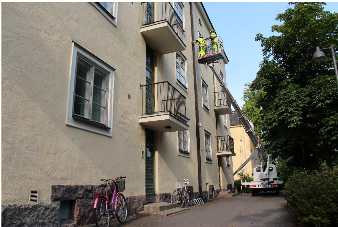
KUVA 6. Sensorit laitettiin paikoilleen nosturin avulla. SP14 sensorin asennus sisäpihalla. KUVA: Nelli kaski/HSY
