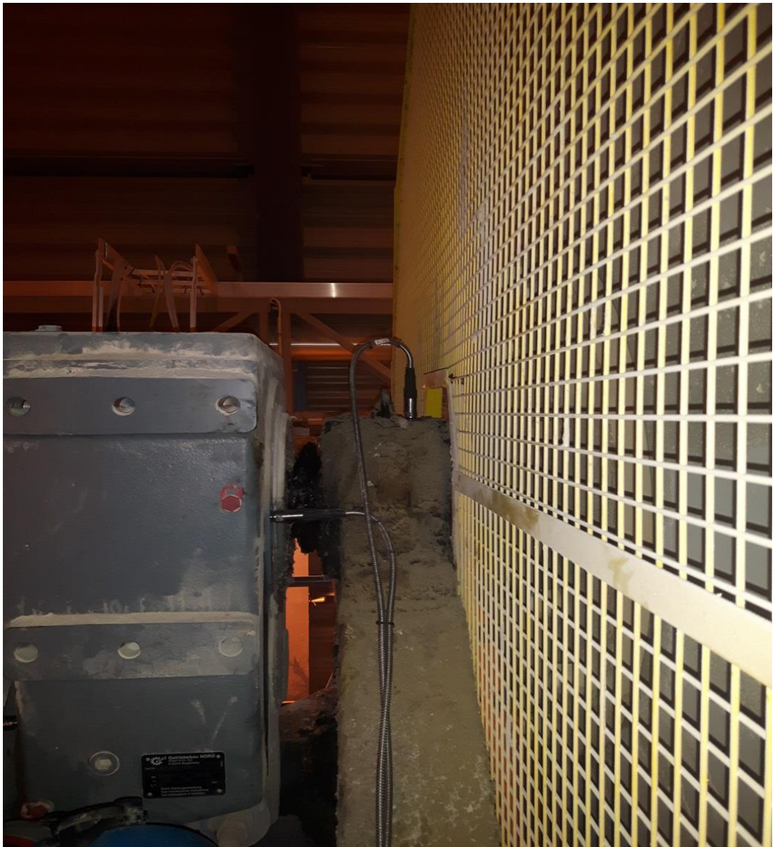
KUVA 64. Päälaakeri ja vaihdelaatikon anturointi (Turunen 2018-03.)
