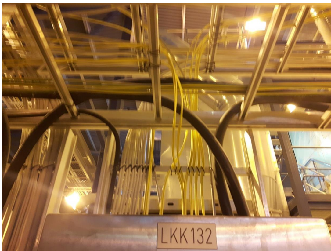
KUVA 62. Mittauskaapelit kaapelihyllylle "kammattuna" (Turunen 2018-03.)
