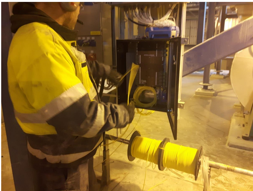
KUVA 59. Mittauskaapeleiden veto mittayksikölle (Turunen 2018-03.)
