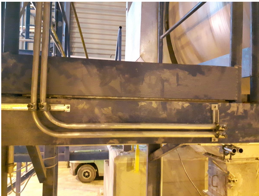
KUVA 57. Mittauskaapeleiden suojausputket (Turunen 2018-03.)
