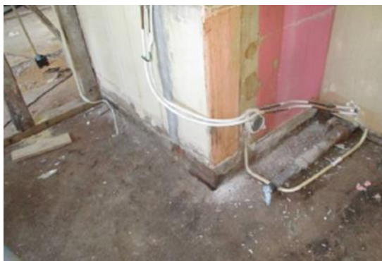
KUVA 14. Keittiön lattian eristetila purettu (Harjumäki 2018-07-23)
