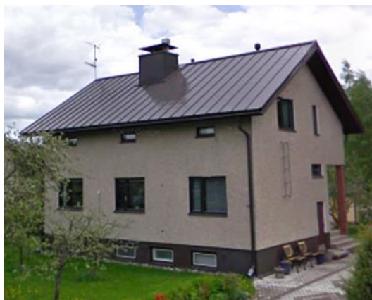
KUVA 3. Korjauskohde (Google Maps 2018-09-15)
