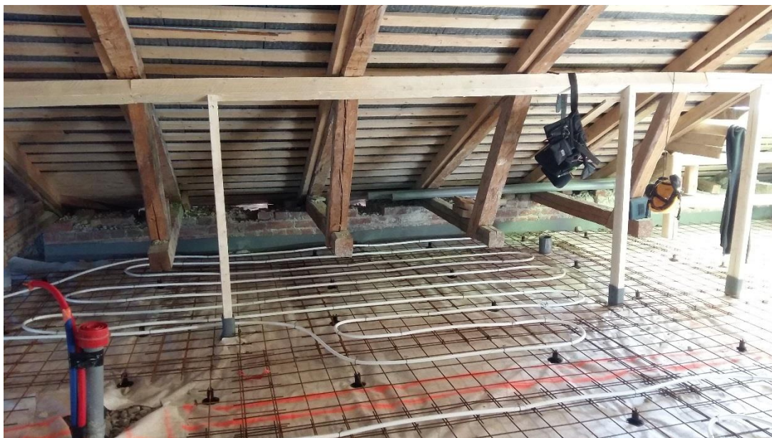
Kuva 7. Lattialämmitysputket (Rautiainen 2018)
