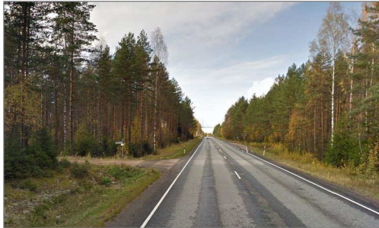
Kuva 36. Valtatien 2 poikkileikkausta ennen parantamista. Vasemmalla Kivisojantien yksityistieliittymä, oikealla alimitoitettu bussipyssäkki. (Google Street View 2011)
