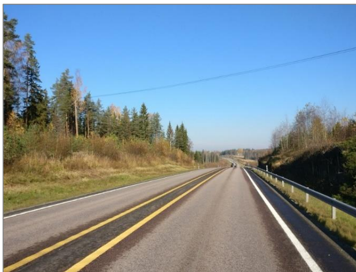
Kuva 23. Keskialueen leveä tiemerkinä Korttelammen levähdysalueen eteläpuolella (Hiekkala 2018).
