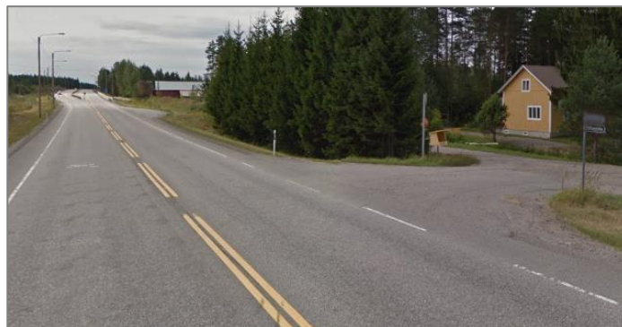
Kuva 19. Kiertotien (yksityistie) liittymä välittömästi keskikaiteellisen ohituskaistajakson jälkeen (Google Street View 2014).
