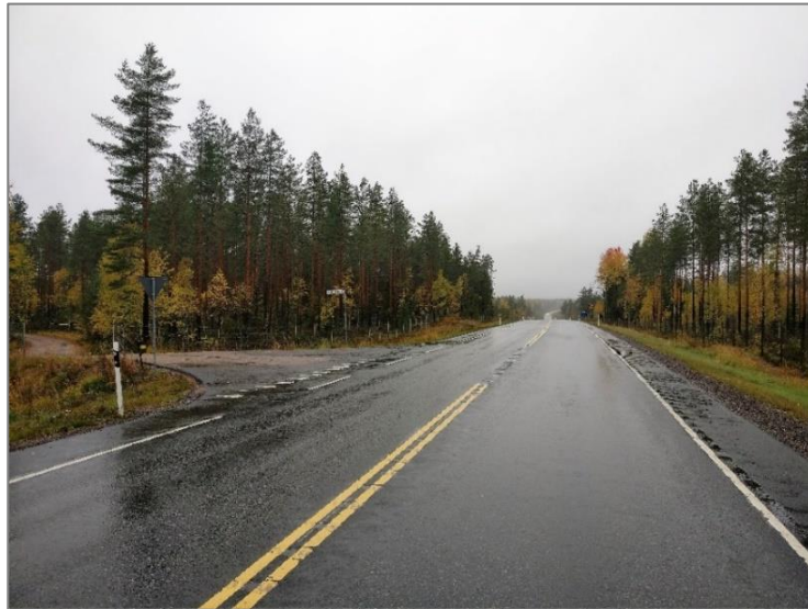
Kuva 40. Jouhtenantien yksityistieliittymä parantamisen jälkeen (Hiekkala 2018).
