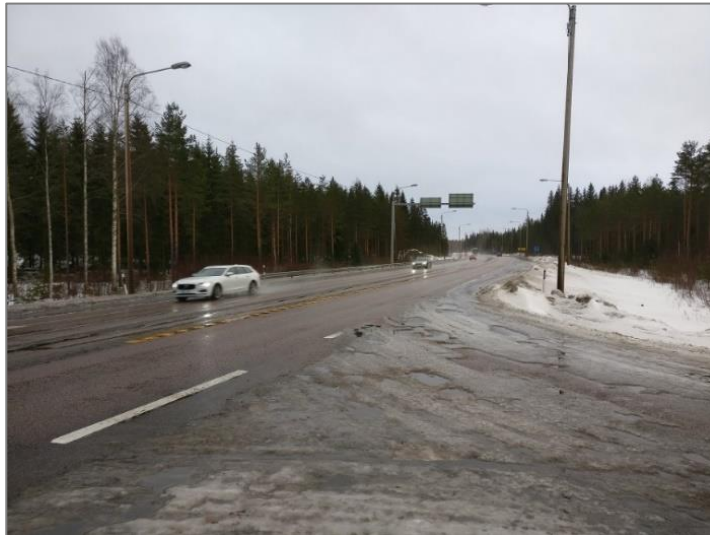
Kuva 32. Jäinen liittymähaara vaikeuttaa liikkeelle lähtöä liittyttäessä pää-tien liikennevirtaan. Liittyvät maantiet tulisi ylläpitää liittymä-alueen osalta samassa talvihoitoluokassa päätien kanssa (Hiekka 2017).
