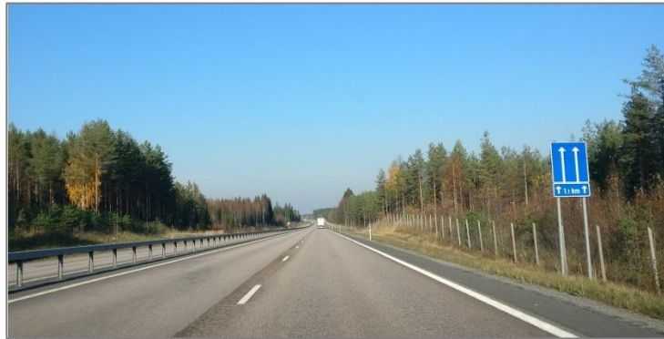
Kuva 17. Juvanharjuntien ylittävän risteyssillan ja Kalhontien välinen 2+2-kaistainen ohituskaistapari (Hiekkala 2018).
