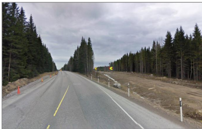
Kuva 22. Rakenteilla oleva Ositunkulman oikaisun eteläpää huhtikuussa 2009 (Google Street View 2009).
