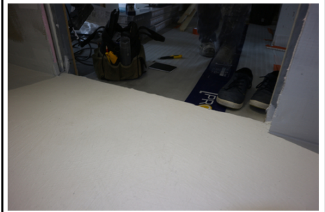
Lähikuva oviaukolta. Tulvakynnysrakenne asentamatta.
