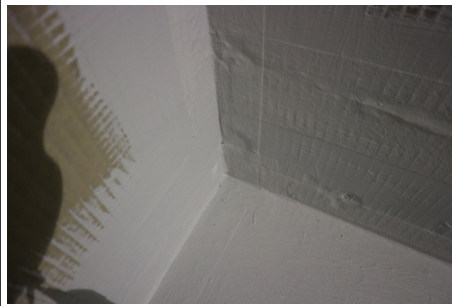
Lähikuva seinä- ja lattiarakenteen liittymäkohdan reiästä.
