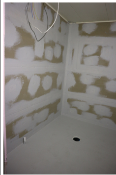
Yleiskuva märkätilasta vedeneristyksen tarkastushetkellä.
