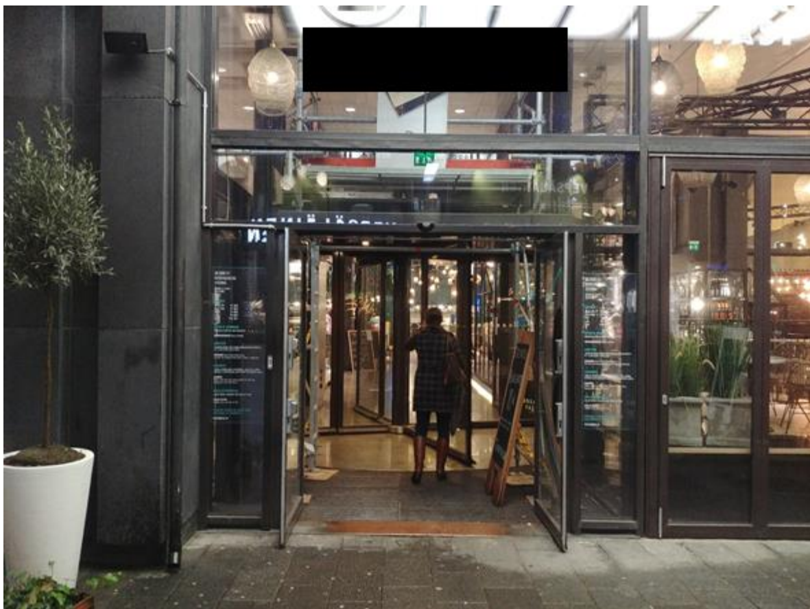
Kuva 7 Tuulikaappiin pystytetyt telineet (Douba, 2018)
