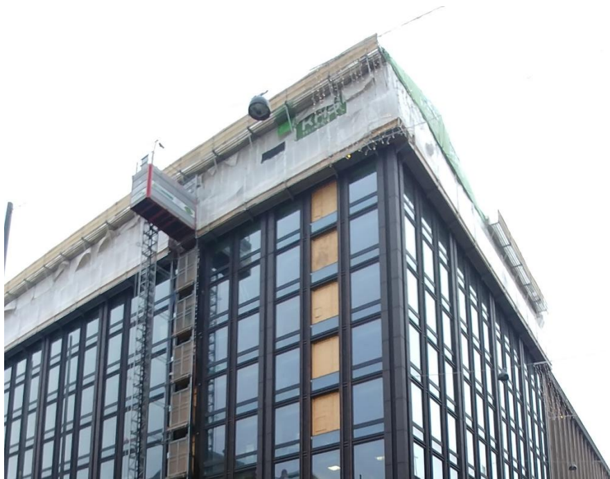
Kuva 2 Työmaan sääsuojaus ja katon putoamissuojaus (Douba, 2018)
