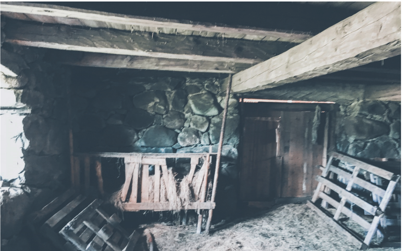
Kuva 28. Särjetyistä kivistä rakennettu kivimuri, muurissa on kiilakiviä tukemassa muurin rakennetta. Kivien koot vaihtelevat suuresti. Kuva otettu Männynmäen kivenavetan metsän puoleisesta päädyistä (Niemi 2018)
