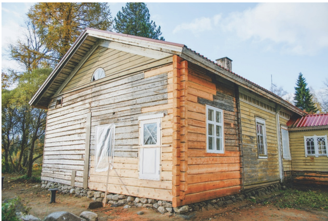
Kuva 10. Ryhälän kappalaispappilan kunnostustöitä syyskuulta 2011 (Sairanen 2011)
