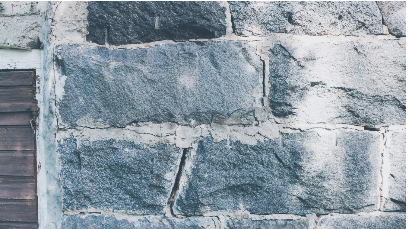
Kuva 27. Männynmäen porakivinavetta, tyypillinen rakenne 1900-luvun alkupuolelta (Niemi 2018)
