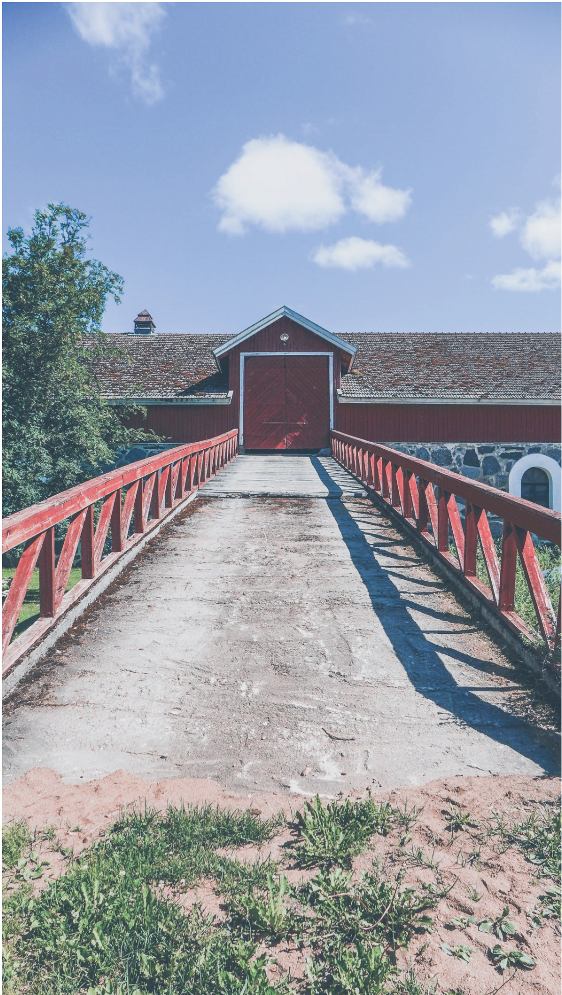
Kuva 14. Wehmaan Kartanon kivi-navetan ajosilta. Navetan ylisille käynti tapahtuu rakennuksen pitkältä sivulta (Niemi 2018)
