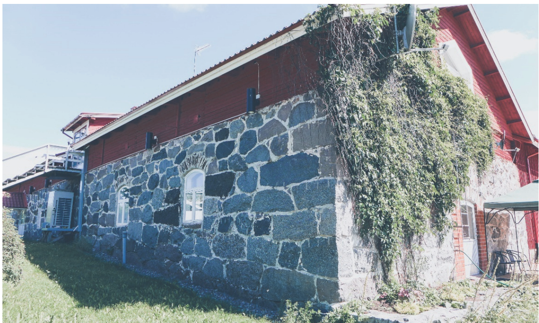
Kuva 20. Partalan kuninkaankartanon takapihan puoleinen julkisivu (Niemi 2018)
