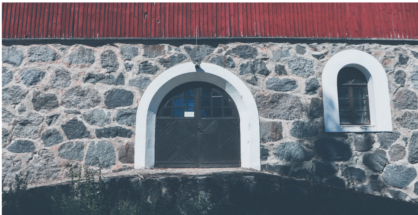
Kuva 29. Wehmaan Kartanon pihattonavetan seinät on tehty pulterikivistä. Alkuperäisiä saumauksia on korjailtu kalkkisementtilaastilla (Niemi 2018)
