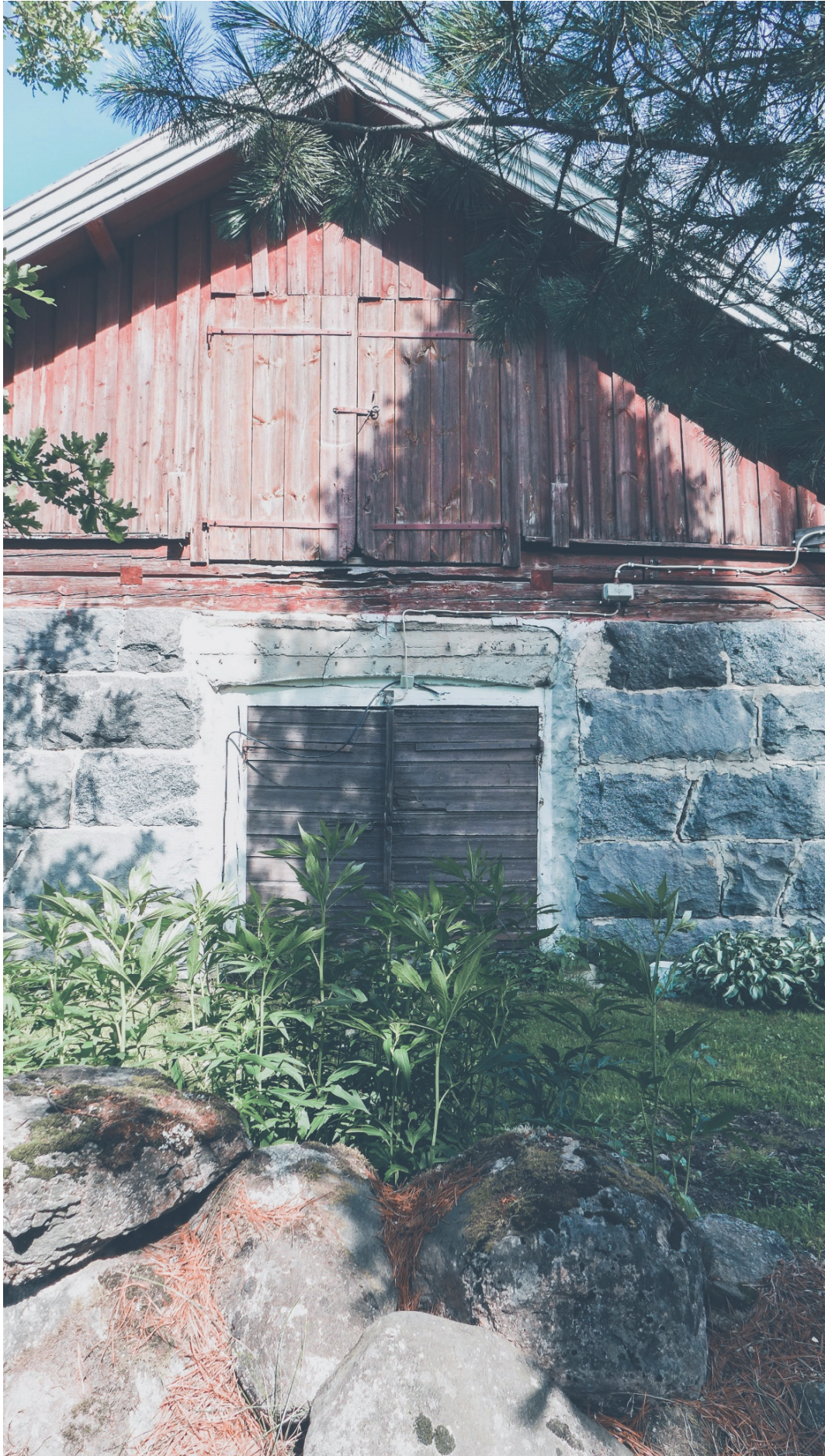
Kuva 15. Ryhälän kappalaispappilan vanha kivinavetta. Navetan ylisille käynti tapahtuu rakennuksen päädystä. Navetan ajosilta ylisille on purettu aikojen saatossa pois (Niemi 2018)
