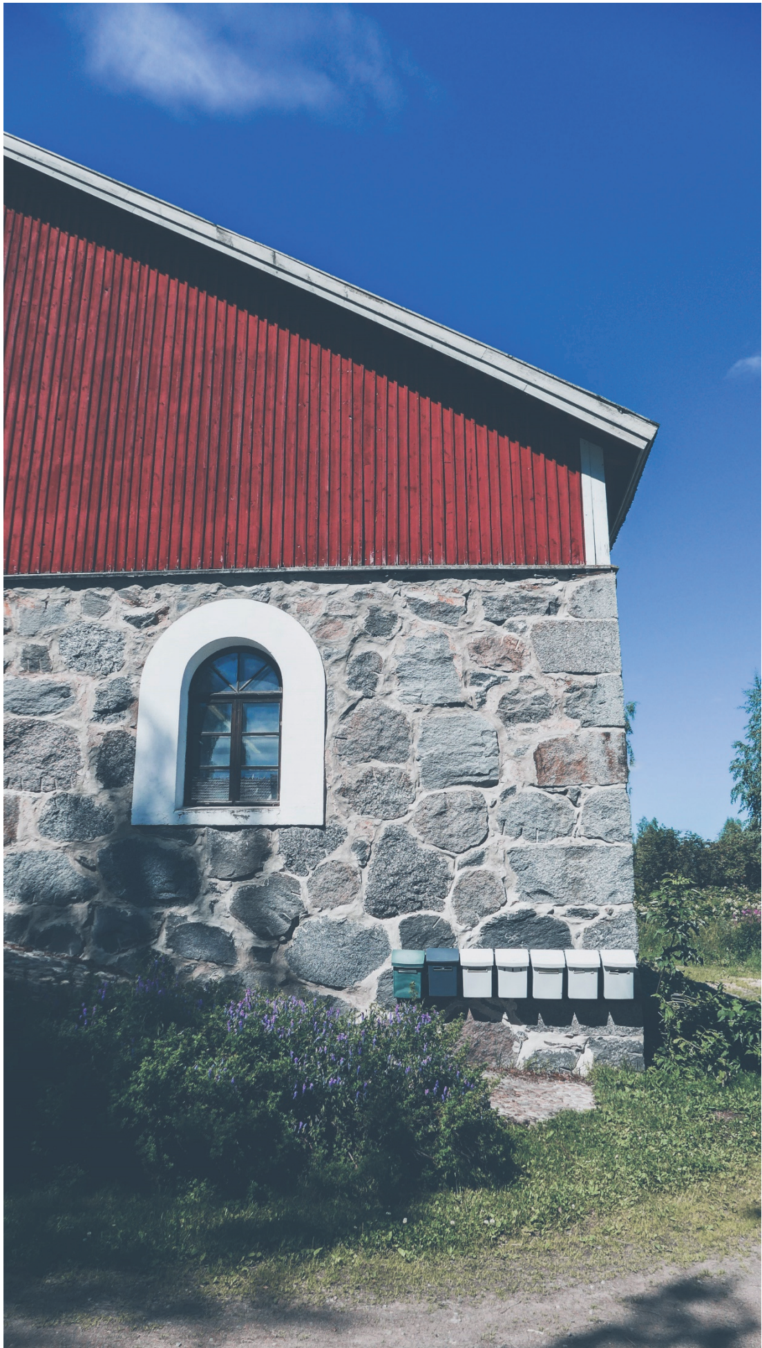
Kuva 18. Navetan ulkoseinää (Niemi 2018)
