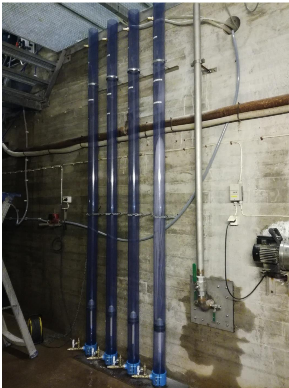
KUVA 11. Kolonnien kaatumisen estämiseksi rakennettiin seinään kiinnitettävät kiinnitysholkit (Heikininen 2018-10-26)
