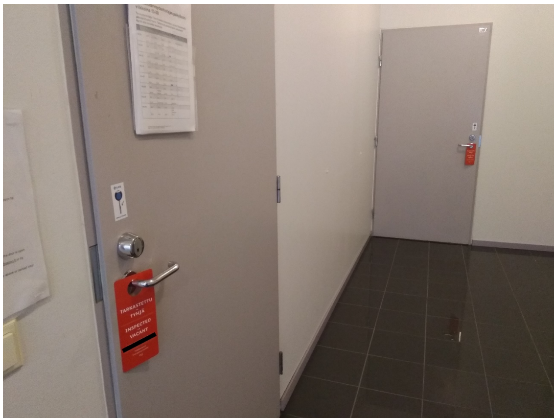
Kuva 11: Tarkastettujen tilojen merkintä "TARKASTETTU - TYHJÄ"-ovimerkeillä
