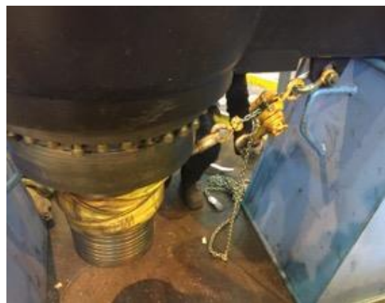
Kuva 94. Liinalla ja taljalla jarrutetaan putkiakselin pyörittämistä (A. Kippo 2018).
