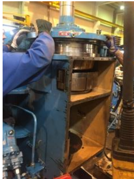
Kuva 76. Kytkin asennetaan paikalleen (A. Kippo 2018).
