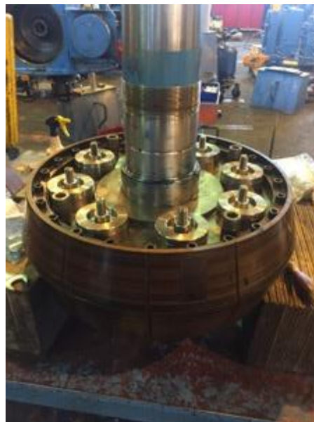
Kuva 56. Kytkin kasattuna ja puhdistettuna uusine jousi kuormitteisin sylintereineen (A. Kippo 2018).
