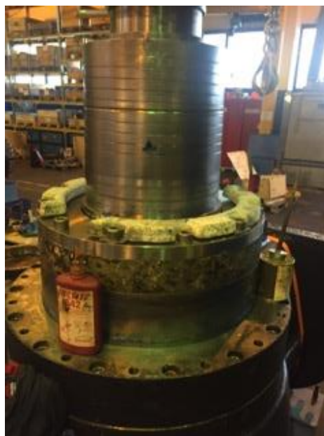
Kuva 97. Laippojen ja sinkkien asentamista potkuriakselille (A. Kippo 2018).
