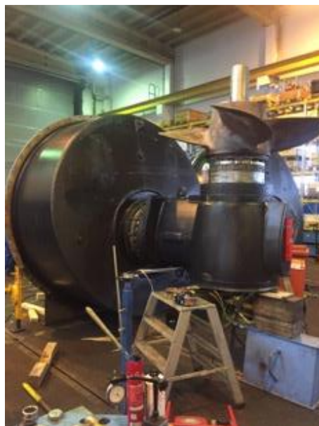
Kuva 110. Alapää paikoillaan (A. Kippo 2018).
