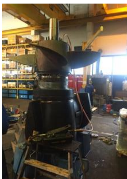
Kuva 101. Potkuria painetaan paikoilleen hydraulimutterilla (A. Kippo 2018).
