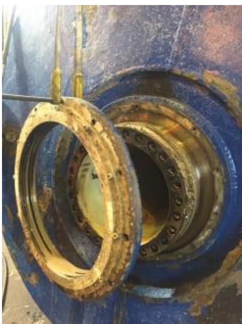
Kuva 30. Tiivistepesä alavaihteen ja väliosan välistä. Renkaan sisällä näkyy meriveteen sekoittunut öljy (A. Kippo 2018).
