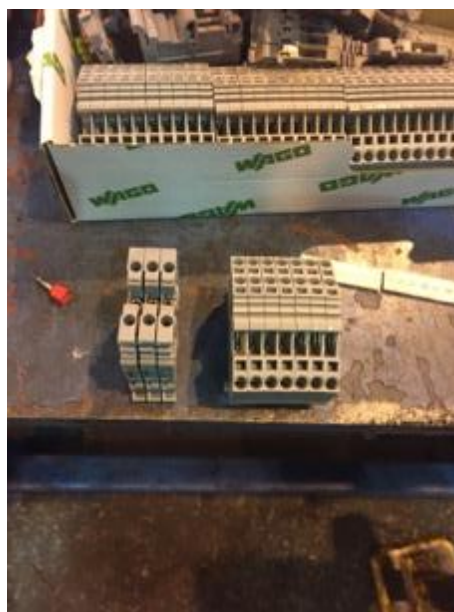
Kuva 108. Uudet liittimet sähköille (A. Kippo 2018).
