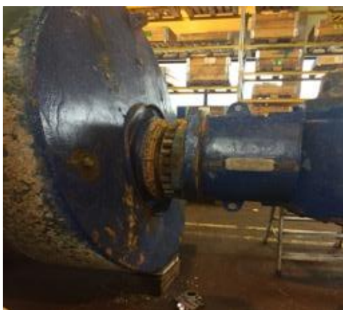
Kuva 14. Köysisuojat poistettu kupumutterien päältä ja pohjakaivoa putsattu simpukoista (A. Kippo 2018).
