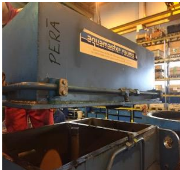
Kuva 42. Öljy tankin purkamista (A. Kippo 2018).
