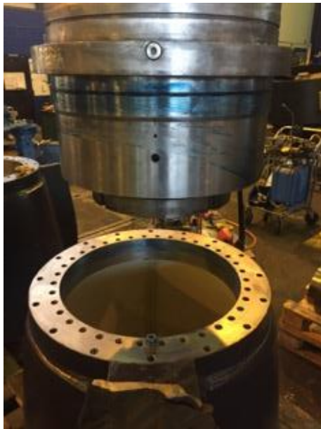
Kuva 87. Putkiakselin asennusta (A. Kippo 2018).
