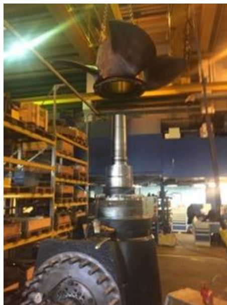
Kuva 99. Potkurin asentamista paikoilleen. Manebar tiiviste paikallaan (A. Kippo 2018).
