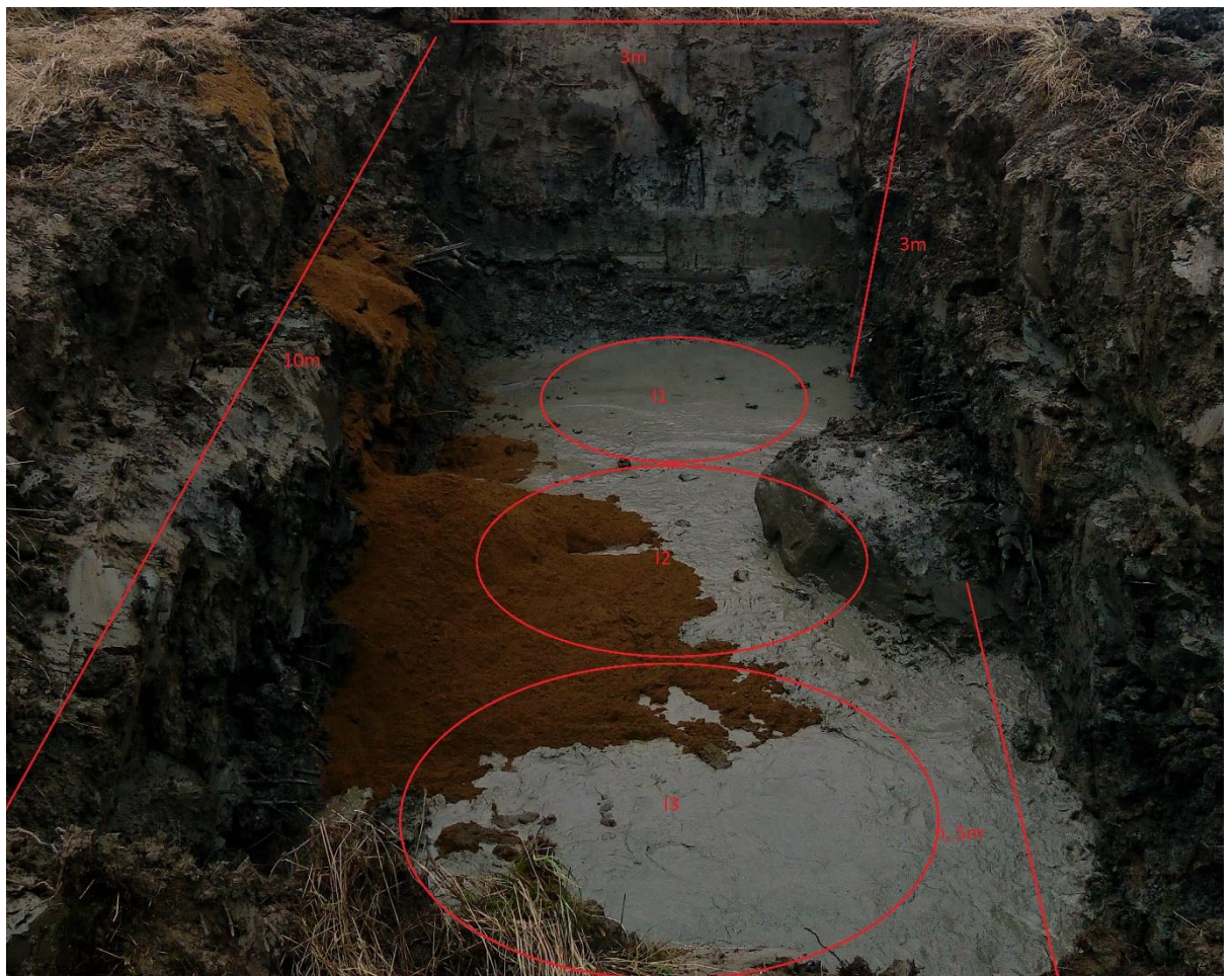
KUVA 8. Injektio pisteiden sijainti injektio kaivannossa (Sjölund 2018)
