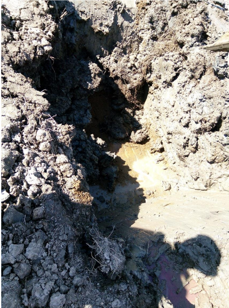
KUVA 17. Toisen injektio pisteen avaus (Sjölund 2018)
