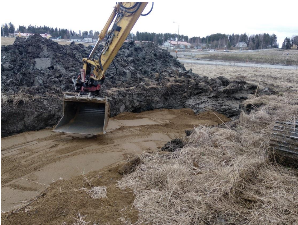
KUVA 12. Kaivannon hiekkapedin tiivistys ja tasaus (Sjölund 2018)
