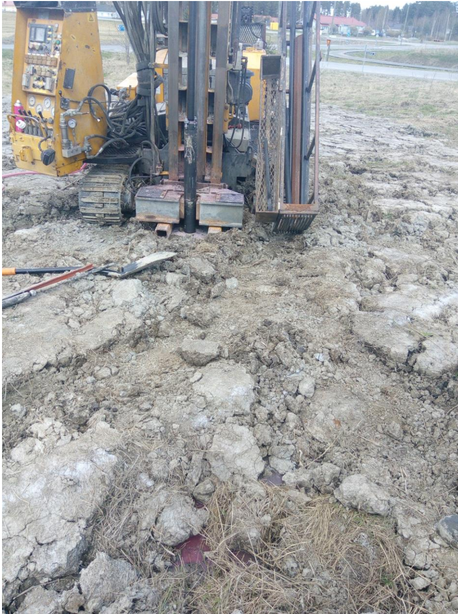
KUVA 18. Väriaine nousee pinnalle muutaman metrin päästä kairakoneesta. (Sjölund 2018)
