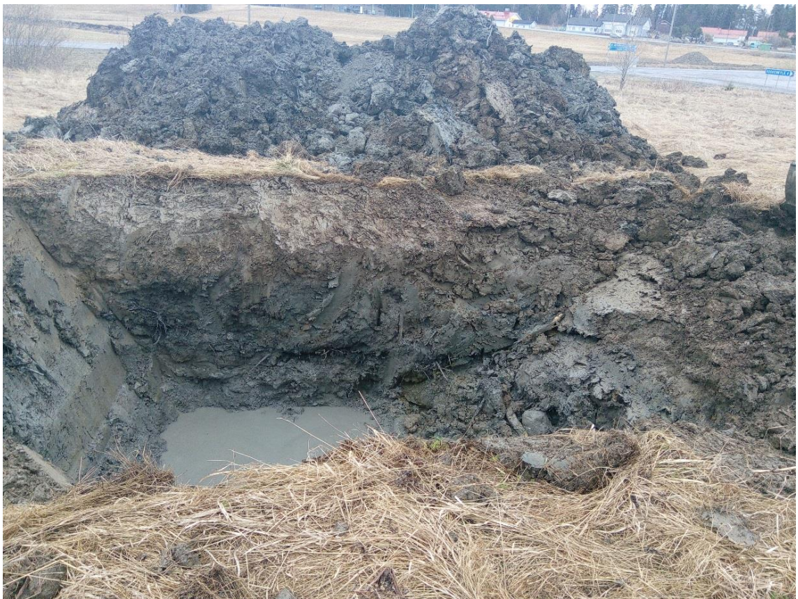
KUVA 9. Kaivuutyön aloitus (Sjölund 2018)
