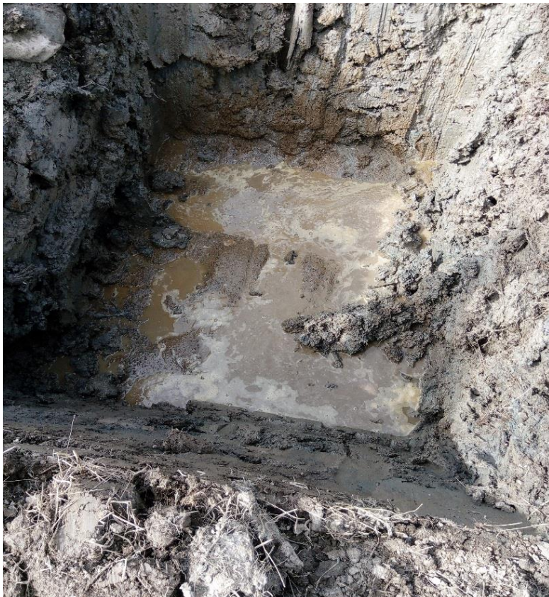
KUVA 16. Injektio kohta 1 heti savikerroksen alapuolella (Sjölund 2018)
