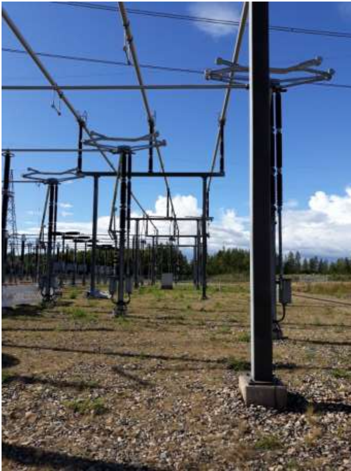
KUVA 4. 400 kV:n saksierotin.
