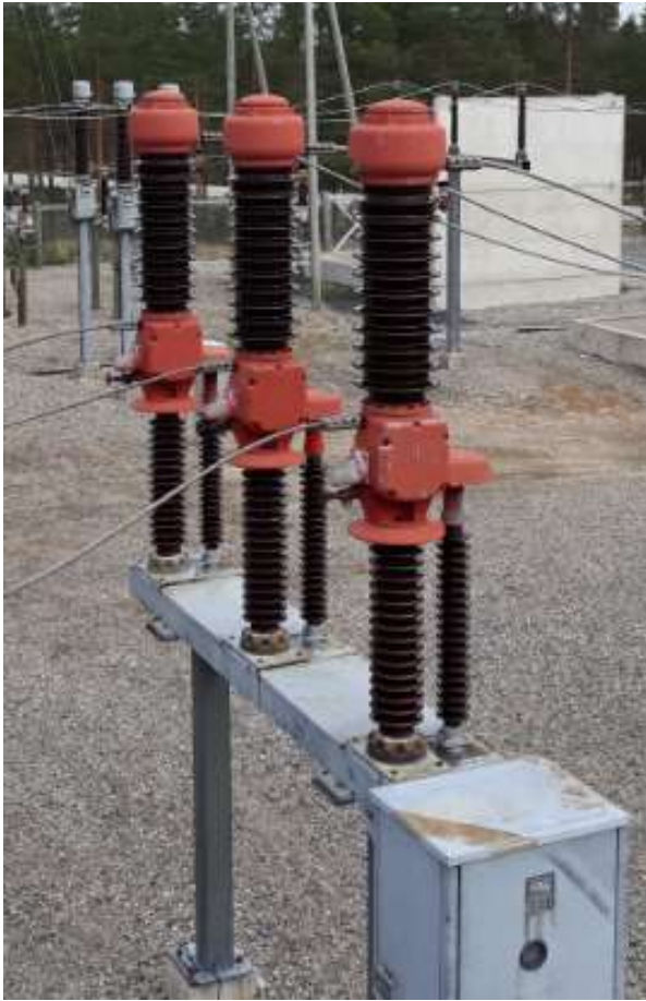
KUVA 3. 110 kV:n vähäöljykatkaisija.
