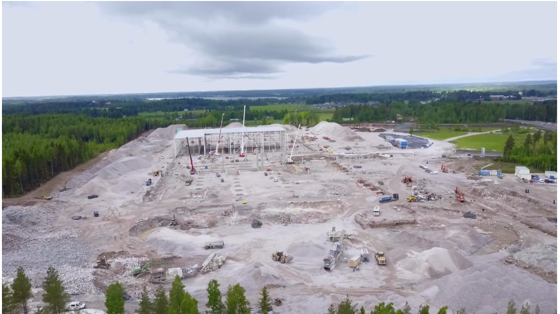
Kuva 7. Yleiskuva työmaasta louhintatyön loppuessa (Partanen 2017).
