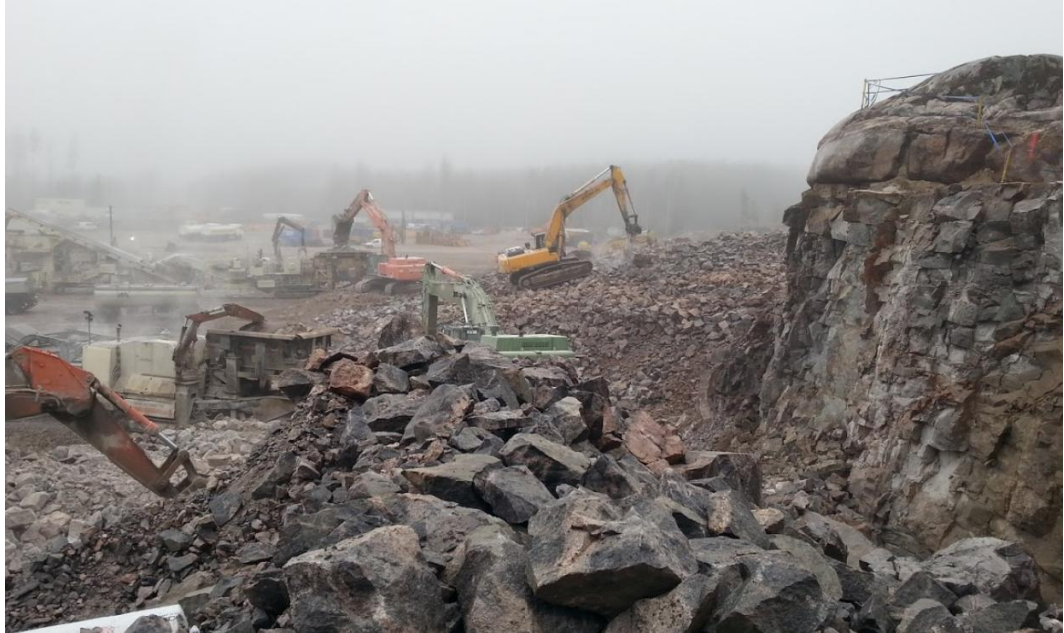
Kuva 4. Pengerlouhinnan jälkeistä esimurskausta ja louheen lastausta (Partanen 2017).
