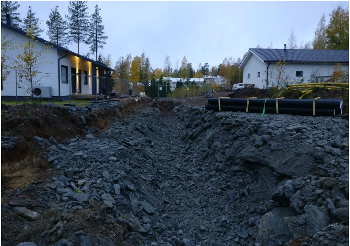
Kuva 16. Louhittu ja raivattu kanaali valmiina vesihuoltotöille (Partanen 2017).
