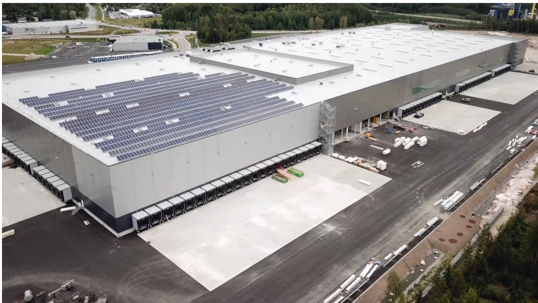
Kuva 8. Murskekasojen paikoille rakennettuja rakenteita (Partanen 2018).
