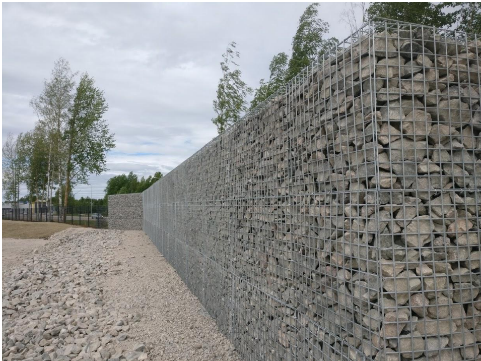
Kuva 6. Murskan jälkeen seulottua KaM #100-150 valmiissa kivikoriaidassa (Partanen 2017).
