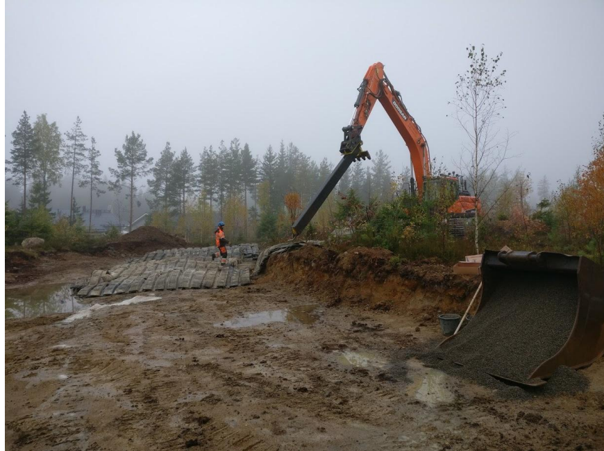
Kuva 14. Viimeisen raskaan kumimaton asennusta. Kauhassa reikien täkkäykseen käytettävää hiekoitussoraa (Partanen 2017).
