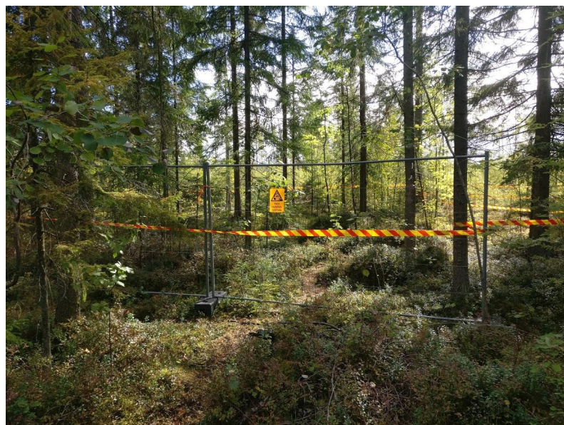
Kuva 15. Työmaan takana olevan metsäalue eristettynä louhintatyöltä (Partanen 2018).
