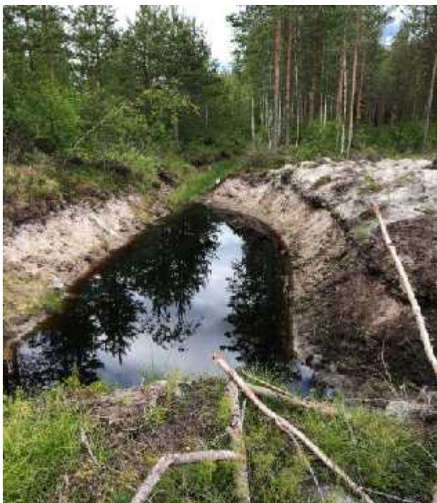
Kuva 8 a. Laskeutusallas 3, Alajärven Pynttärissä. Kuvattu puhelimen kameralla. (Pyhälähti 2018.)
