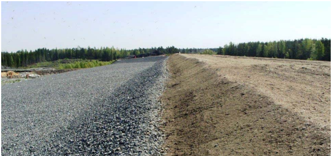
KUVA 10. Liitosrakenne ja vanhan jätetäyttöalueen pintakerros
