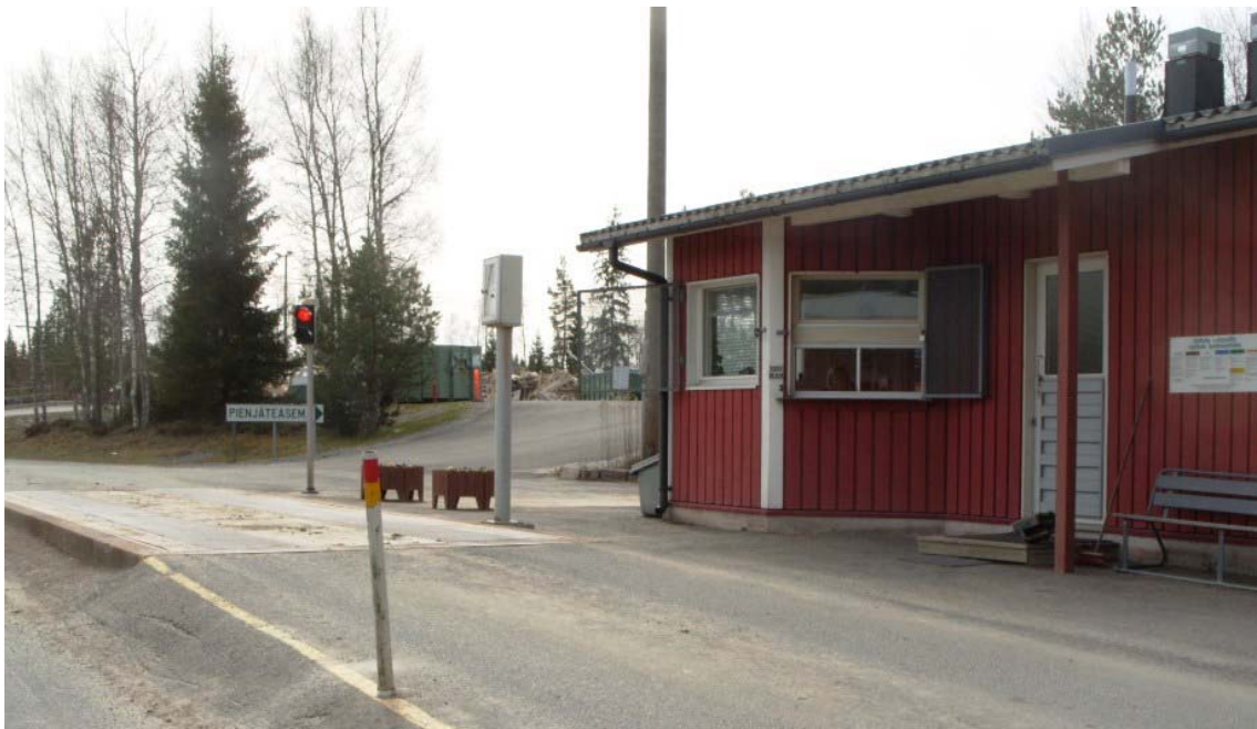
KUVA 1. Jäteaseman toimisto- ja sosiaalityilat sekä autovaaka
