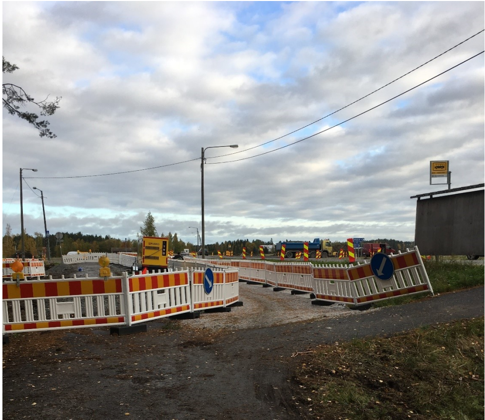
Kuva 18. Liikenteenohjauslaitteita maantiellä 2012 Ruskossa, kiertoliittymän rakennustyömaa. Selkeät ohjeistukset kevyenliikenteenväylällä.
