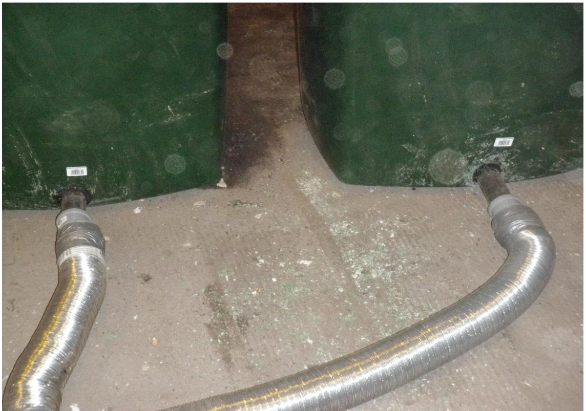
Kompostoreiden ilmastusputkien läpivientiä varten jouduttiin poraamaan kompostoreihin suuremmat reiät.
