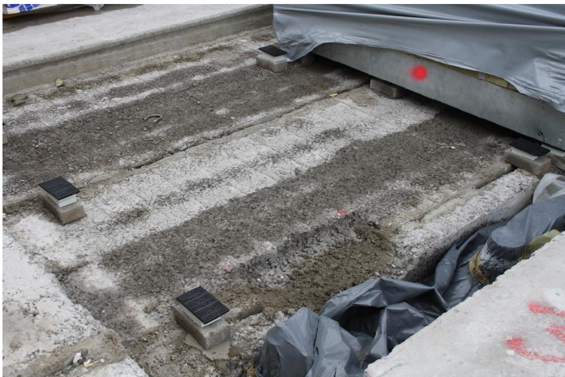
Kuva 2. Oikeassa korkeudessa olevat asennuspalat (Parmarine 2018)
