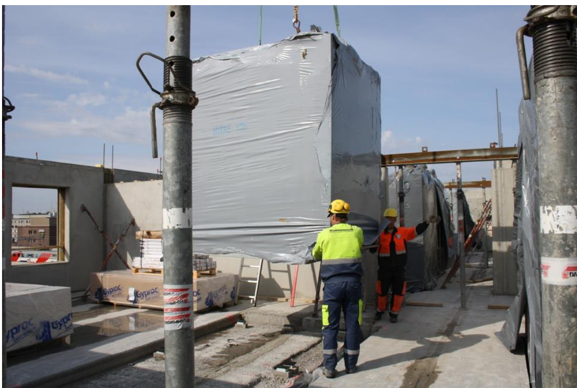
Kuva 5. Elementin laskeminen oikealle paikalle (Parmarine 2018)
