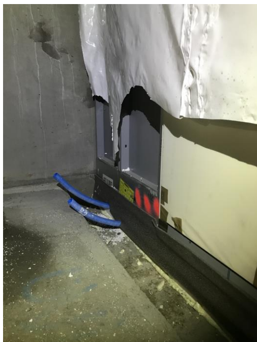
Kuva 12. Reunavalun tukko ja tuuletusputket asennettuna
