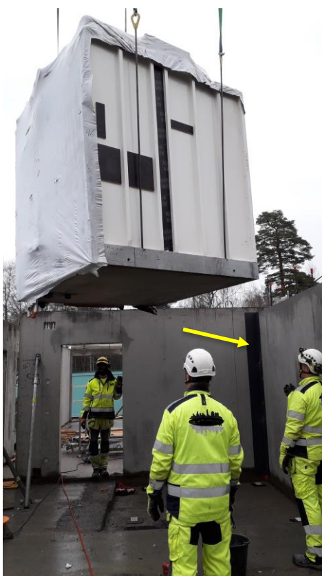
Kuva 11. Kylpyhuoneen taakse jäävän seinäelementin pystysauman tukko asennettuna.
