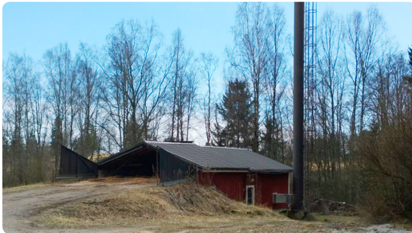
Bild 35. Flisvärmecentralen i Västankvarn. (Foto: Engelbert Engblom)
