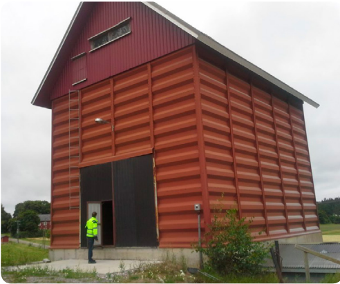
Kuva 43. Hakelämmöllä toimiva viljankuivuri. (Kuva: Juha Tiainen)
