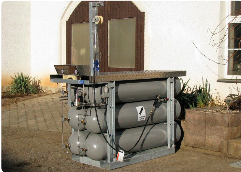
Kuva 4. Tyypillinen kotitankkauslaitteisto pullopattereineen (Compressor technology 2017).
