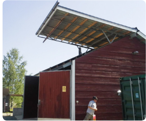
Kuva 49. Hakevarastossa ja -kuivaamossa on avattava katto hakeautojen vaivatonta purkua varten. (Kuva: Juha Tiainen)
