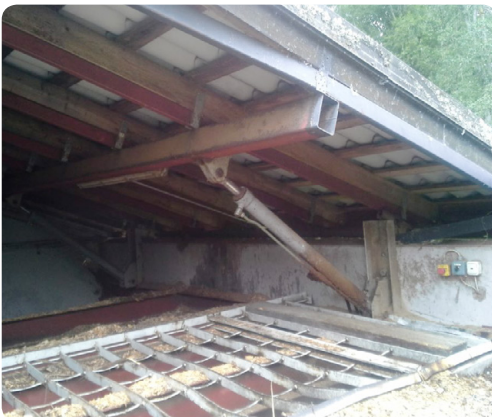
Kuva 41. Hydraulisesti avattava katto ja hakevaraston päällä oleva ritilä. (Kuva: Juha Tiainen)
