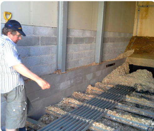
Kuva 50. Hakevaraston purku syöttöön tapahtuu alakautta tankopurkaimien avulla. (Kuva: Juha Tiainen)
