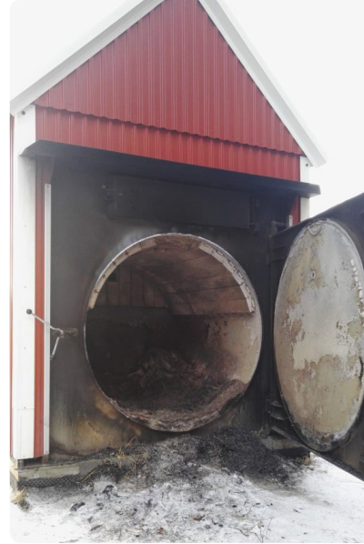
Kuva 59. Kokopaalikattila sisäpuolelta. (Kuva: Riina Lahtomäki)
