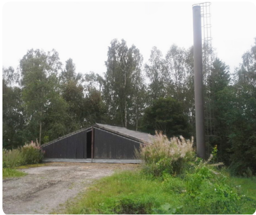
Kuva 40. Hakelämpölaitos, jonka katto on kokonaan avattavissa, joten purku hakeautosta tai -peräkärrystä on helppoa (kts. Kuva 49). (Kuva: Juha Tiainen)
