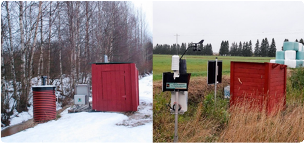
Kuva 93. Vasen kuva: Pohjoisen kaivon mittauslaitteisto. Oikea kuva: Eteläisen kaivon mittauslaitteisto ja säähavaintoasema. (Kuva: Kaija Karhunen)
