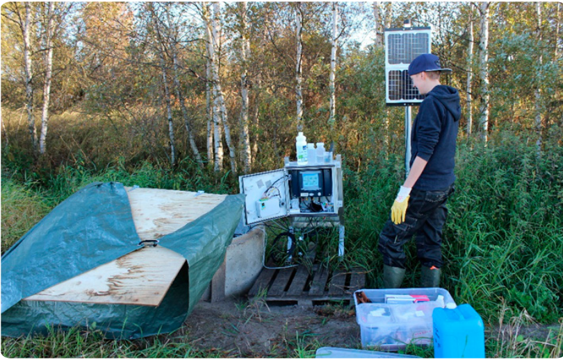
Kuva 90. Pohjoisen kaivon mittausjärjestelmä. (Kuva: Kaija Karhunen)
