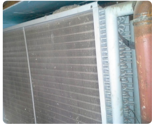
Kuva 44. Viljankuivurin lämmönvaihdin, johon johdetaan lämpöenergia reilun puolen kilometrin päässä olevasta lämpökeskuksesta lämpökanaaleilla. (Kuva: Juha Tiainen)
