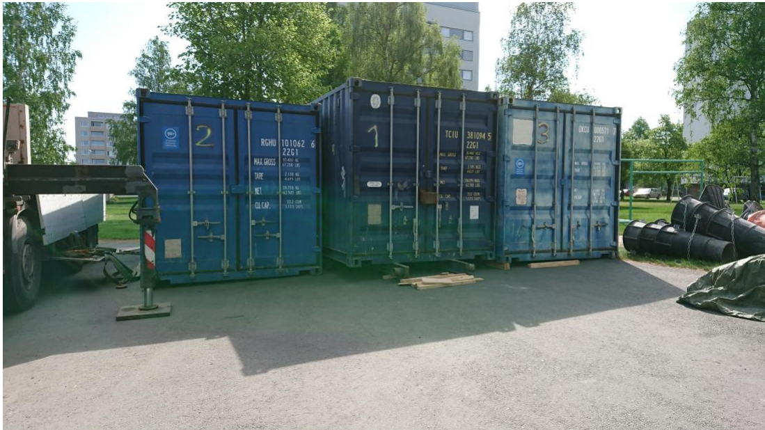
Kuva 10, tilavan pihan ansiosta työmaakontit saadaan asennettua paikkaan, jonka ansiosta työmaalla kulku on helppoa ja pääsy konteille on nopeaa.
