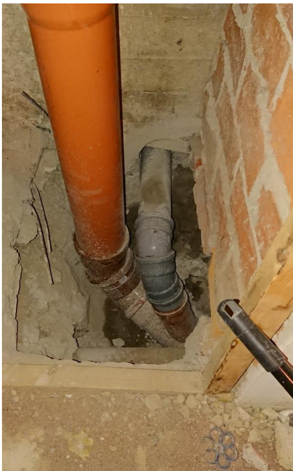
Kuva 7, yksinkertaisen viemäriiitoksen takia jouduttiin sekä etsimään että kaivamaan vanha putki esiin, jonka tarkka sijainti ei näkynyt vanhoissa kuvissa.
