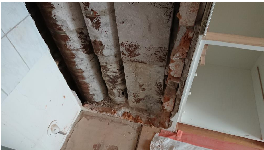
Kuva 5, vanhojen hormissa sijaitsevien iv-kanavien takaa ilmeni asbestia, joten purkutyöt jouduttiin suorittamaan asbestipurkuina työturvallisuussyistä.
