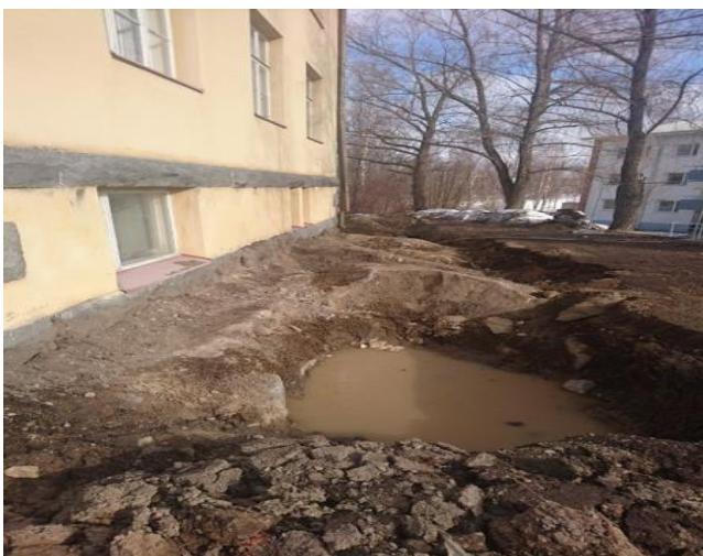
KUVA 16. Viemärikaivanto ennen louhimista
