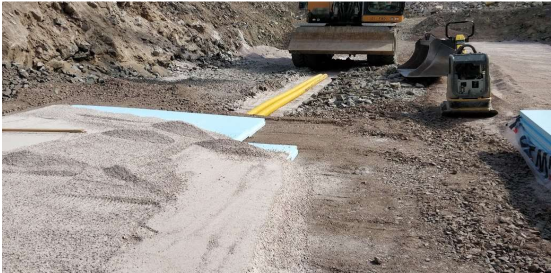
Kuva 10. XPS-levyjen sekä kaapelinsuojaputkien asentaminen
