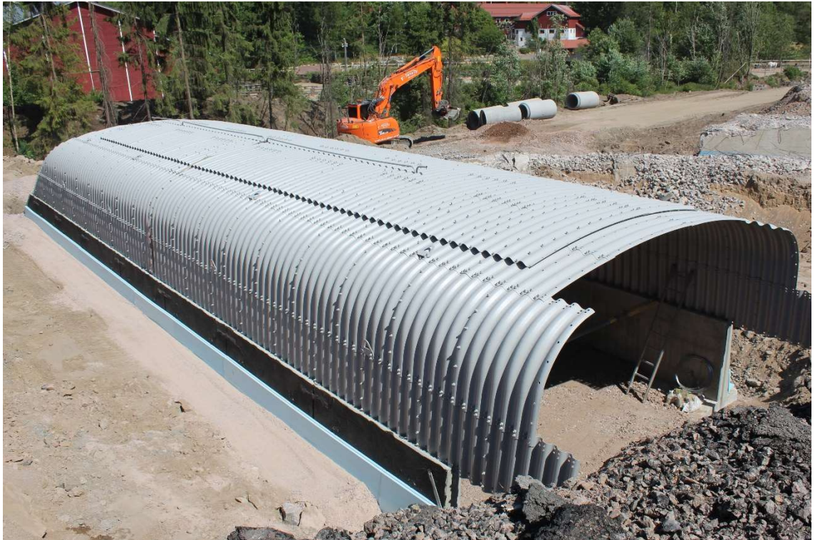
Kuva 12. Ensimmäisen vaiheen teräskaaret betonianturoiden päällä
