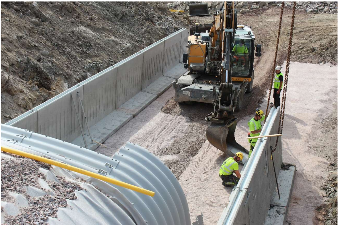
Kuva 11. Perustuselementtien asentaminen
