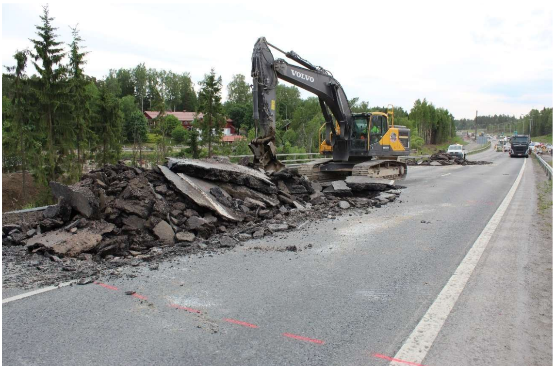
Kuva 9. Asfalttipäällysteen kaivaminen
