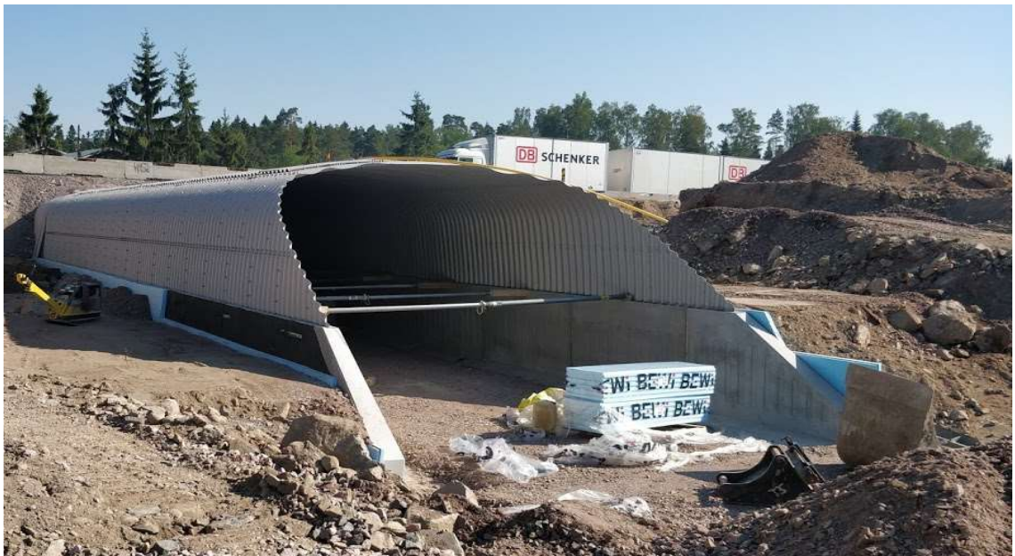
Kuva 13. Kumibitumisively ja vaakasuuntaiset tuet
