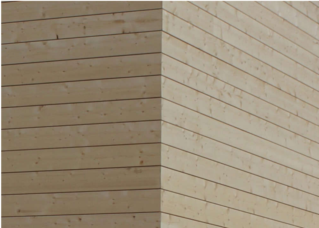
KUVA 17. Pluspuu-talovalmistajan moderni nurkkatyyppi. (Pluspuun www-sivut )
