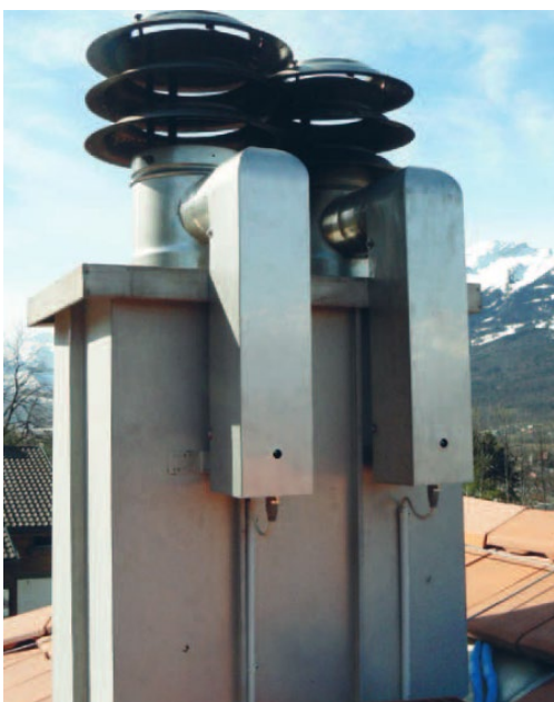
KUVA 38. Oekotube sähkösuodatin (Oekosolve.ch).
