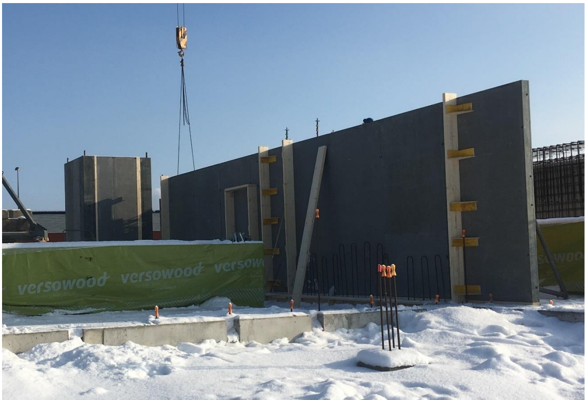
Kuva 9. Muottipuolisko ja rajoittimet paikoilleen asennettuna
