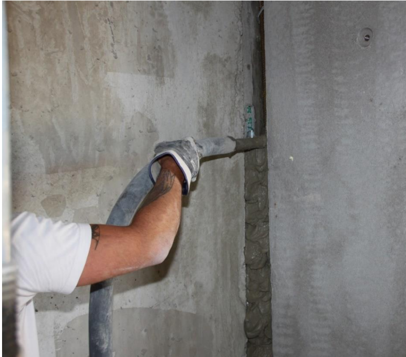
Kuva 6. Pystysaumabetonointi käynnissä (Fescon 2013)
