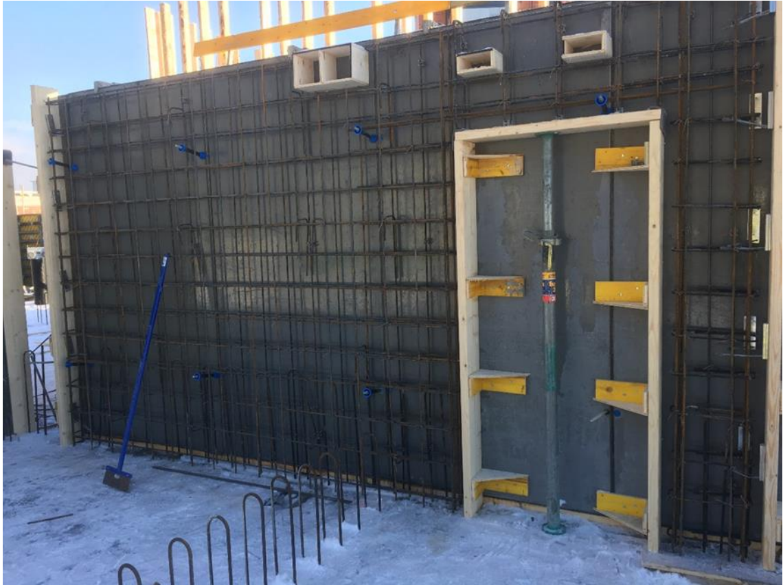
Kuva 10. Raudoitettu seinä valmis lämpölankojen asennusta varten
