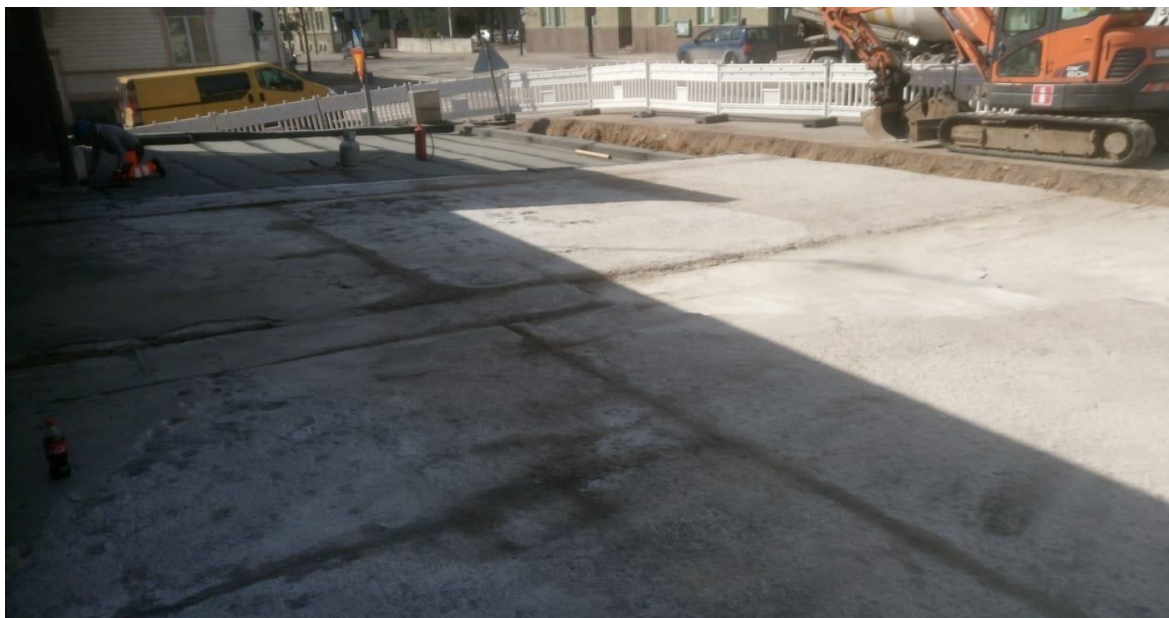
Figur 5. Området som fick nytt vattentätt skikt. På det filtbelagda området kommer nybyggnaden. (Foto: Axel Pitkänen)
