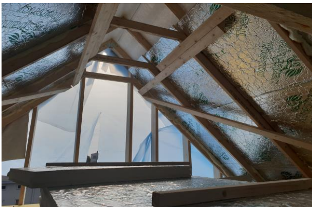
Figur 17. Isoleringsarbete i tekniskt utrymme. (Foto Axel Pitkänen)
