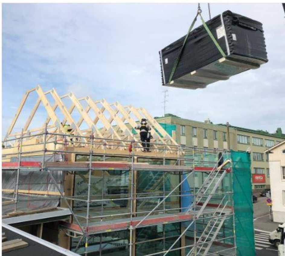
Figur 16. Takstolsmontering slutförd. (Foto Axel Pitkänen)
