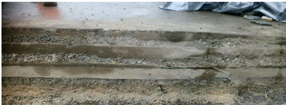
Figur 3. Materialet som revs innan man kom ner till valvet bestod av två lager asfalt, betong, tujaskiva och leca grus. (Foto Axel Pitkänen)
