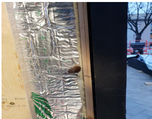
Figur 18. Skärning av väggen i praktiken. (Foto Axel Pitkänen)
