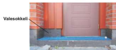
Havainnekuva valesokkelista. Sokkelin yläpinta ylempänä oven kynnystä.
