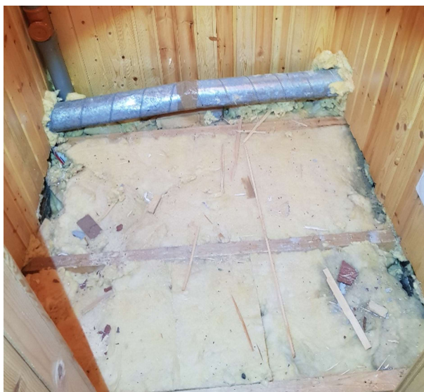
KUVA 7. Vaatehuoneen alapohjarakenne (Pulkkinen 2018-09-22)
